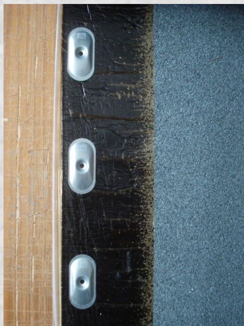
správné umístění kotevních prvků
