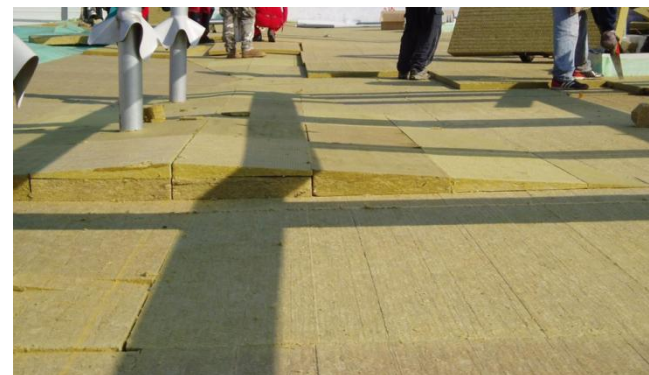
Pohled na spádové desky systému ROCKFALL ( http://pruvodce.rockwool.cz/media/70004/ploche%20strecehy%20cz.pdf )
