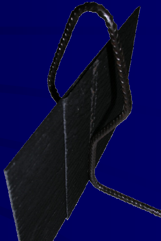
Spojení a zafixování plechu pomocí \Omega -spony
