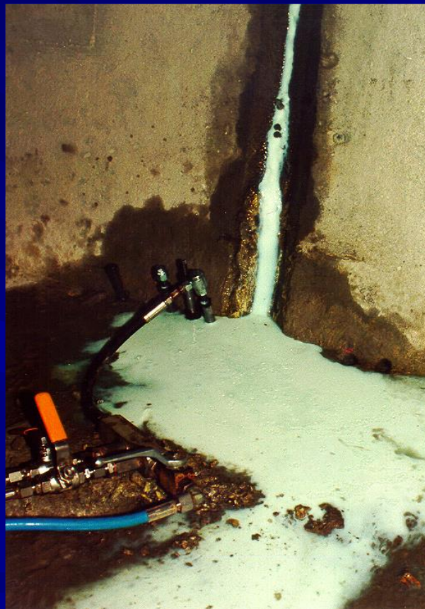
Injektáž svislé pracovní spáry
