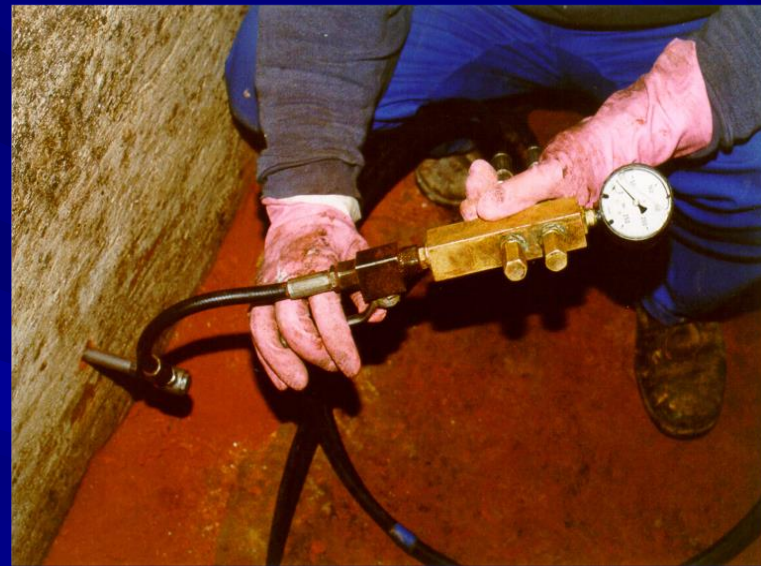
Injektáž malým tlakem do zeminy
