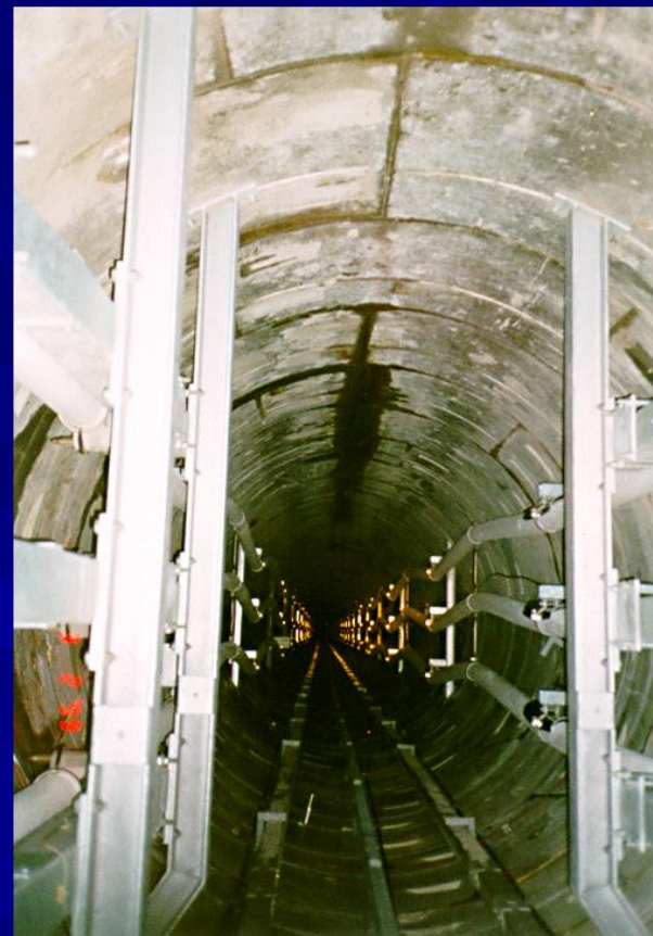
Tunel z tubinkové konstrukce
