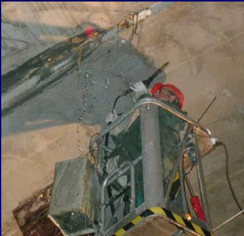
Injektáž (předinjektáž) polyuretanovými pryskyřicemi
