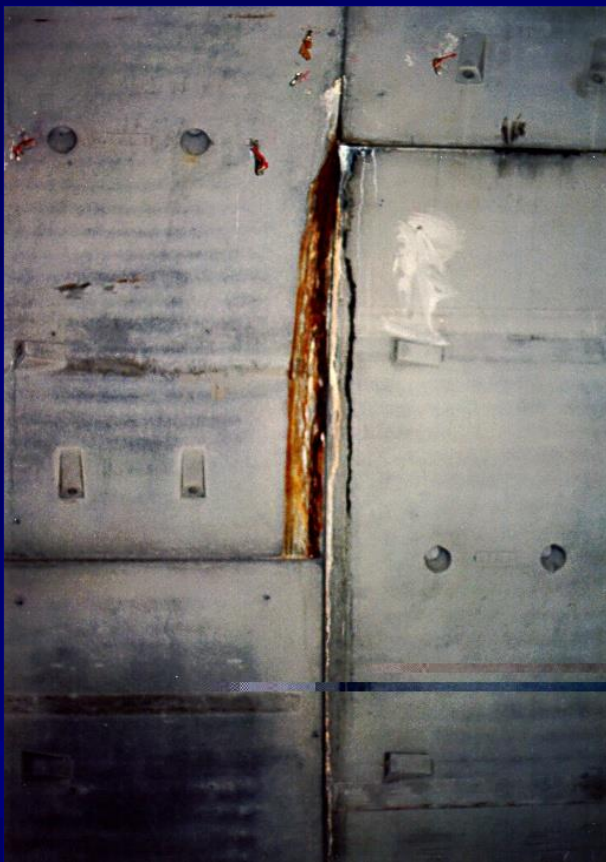
Měkké spáry tubinek injektované gely
