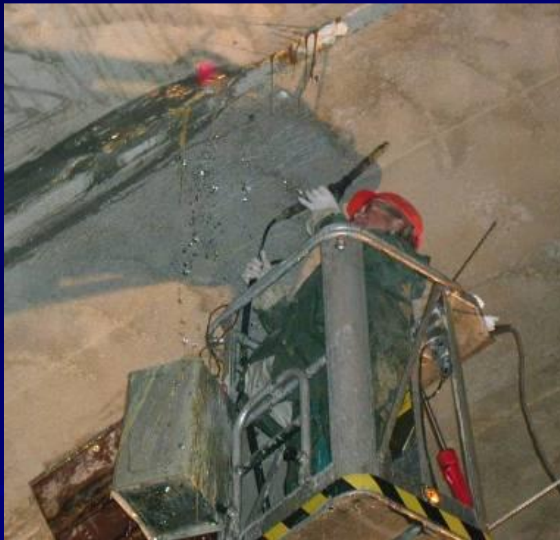
Injektáž (předinjektáž) polyuretanovými pryskyřicemi
