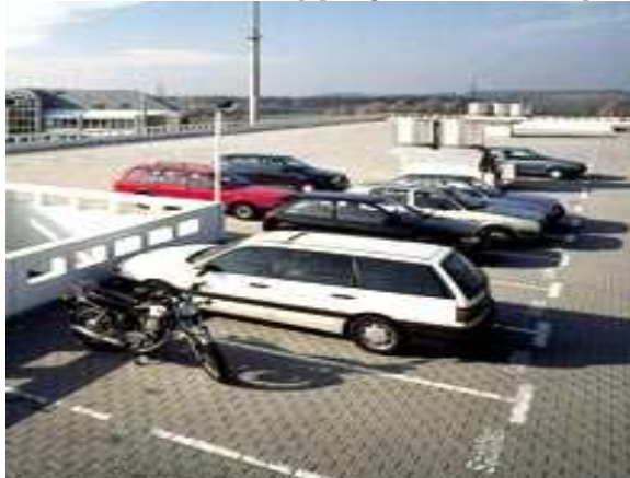
► Dlažba do pískového lože
