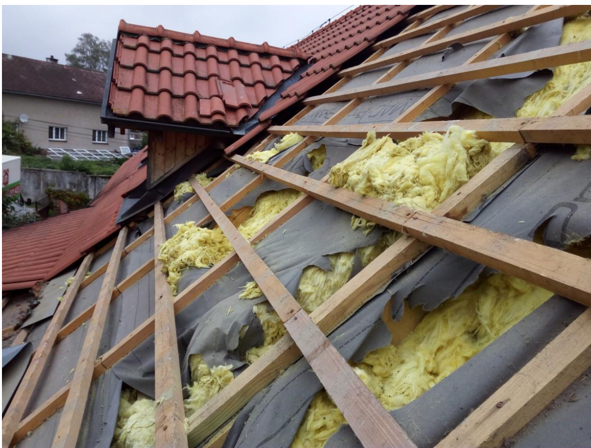
chybějící izolace mezi krokvy (něco podobného jsem zaměřila i na termovizi)
