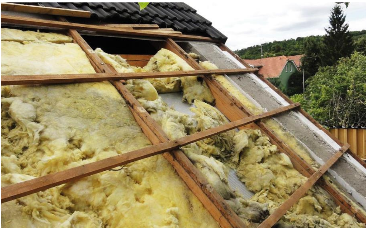
chybějící izolace mezi krokvy (něco podobného jsem zaměřila i na termovizi)
