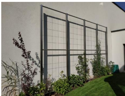
Obrázek 13: Lankový systém se ztužujícím rámem
