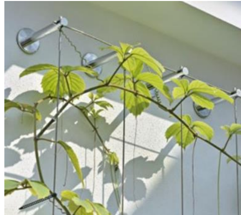
Obrázek 25: Samopnoucí fasáda s podporou z ocelových lan
