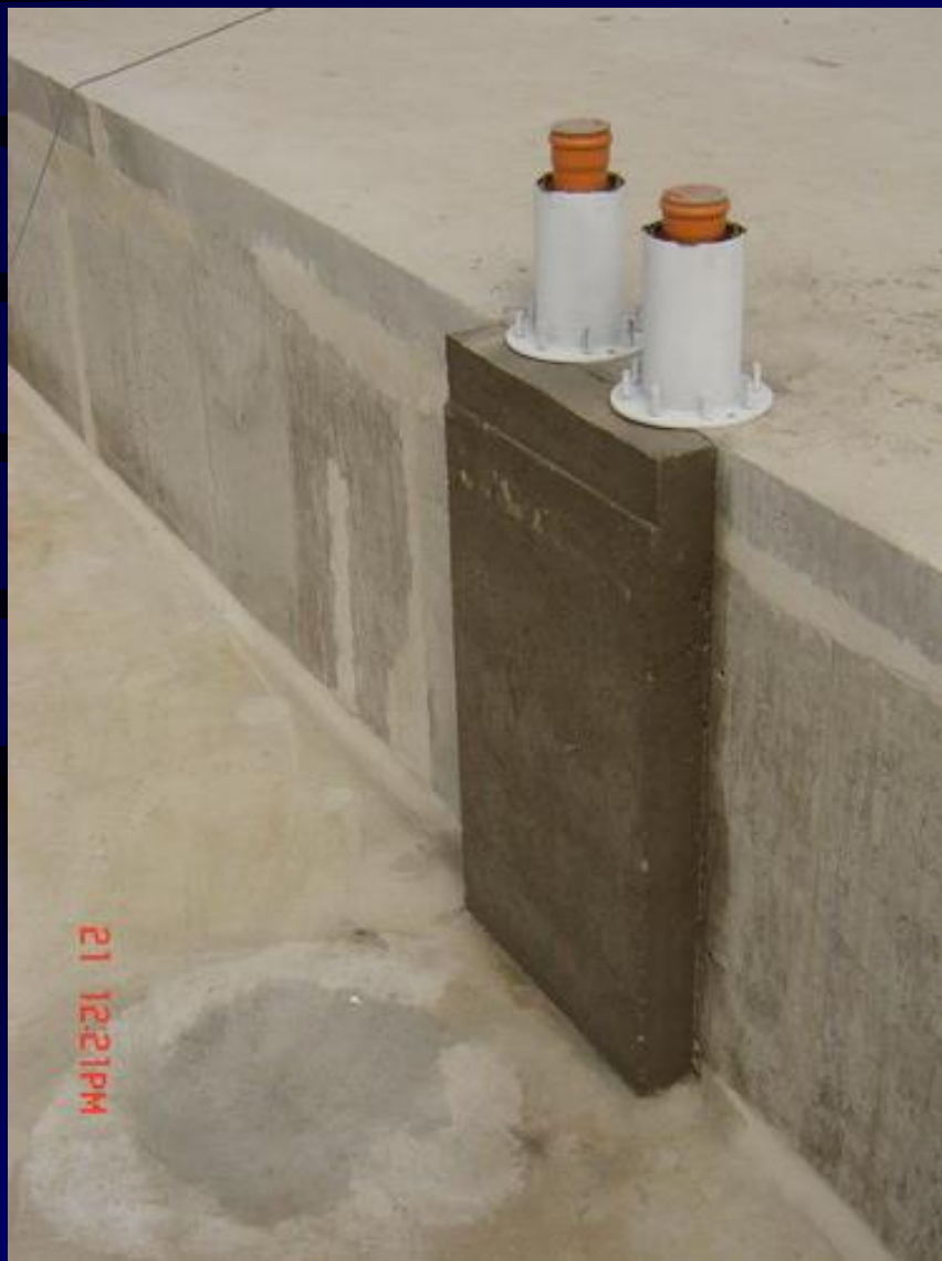
Koutové a rohové tvarovky zesilující hydroizolaci 76
