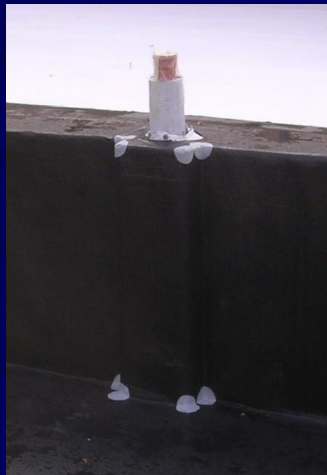
Koutové a rohové tvarovky zesilující hydroizolaci 76
