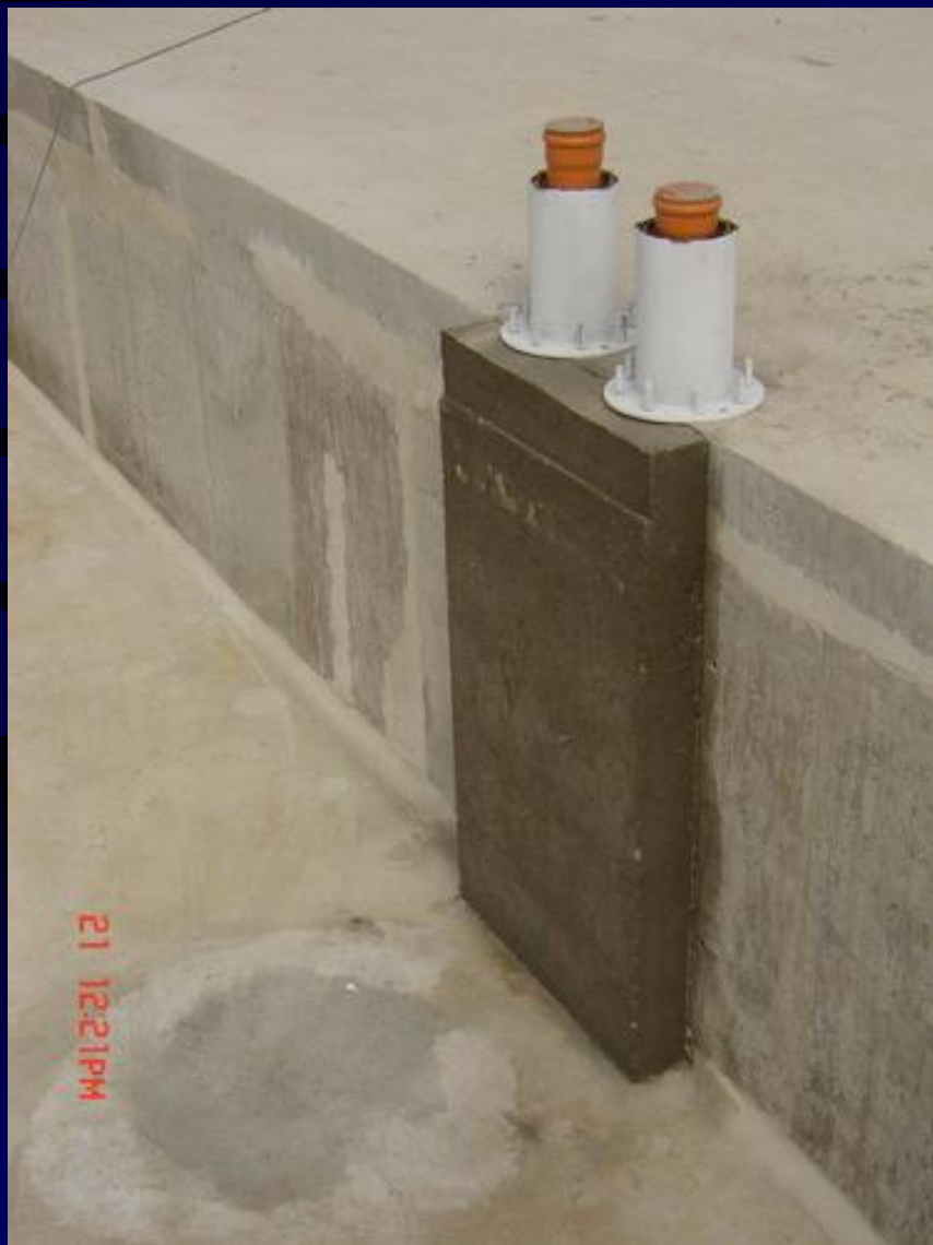
Koutové a rohové tvarovky zesilující hydroizolaci 93
