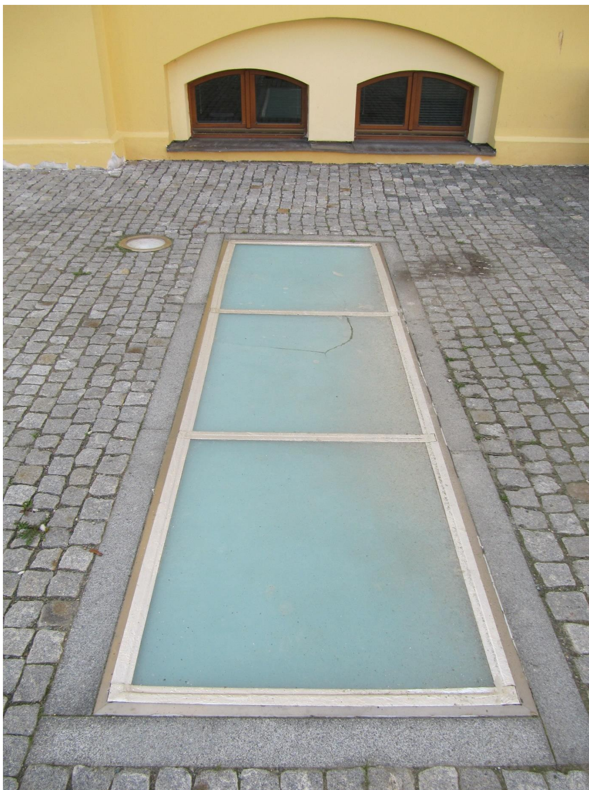
Obr. č. 2 – Pohled na pochozí okno sanované samolepící asfaltovou páskou
