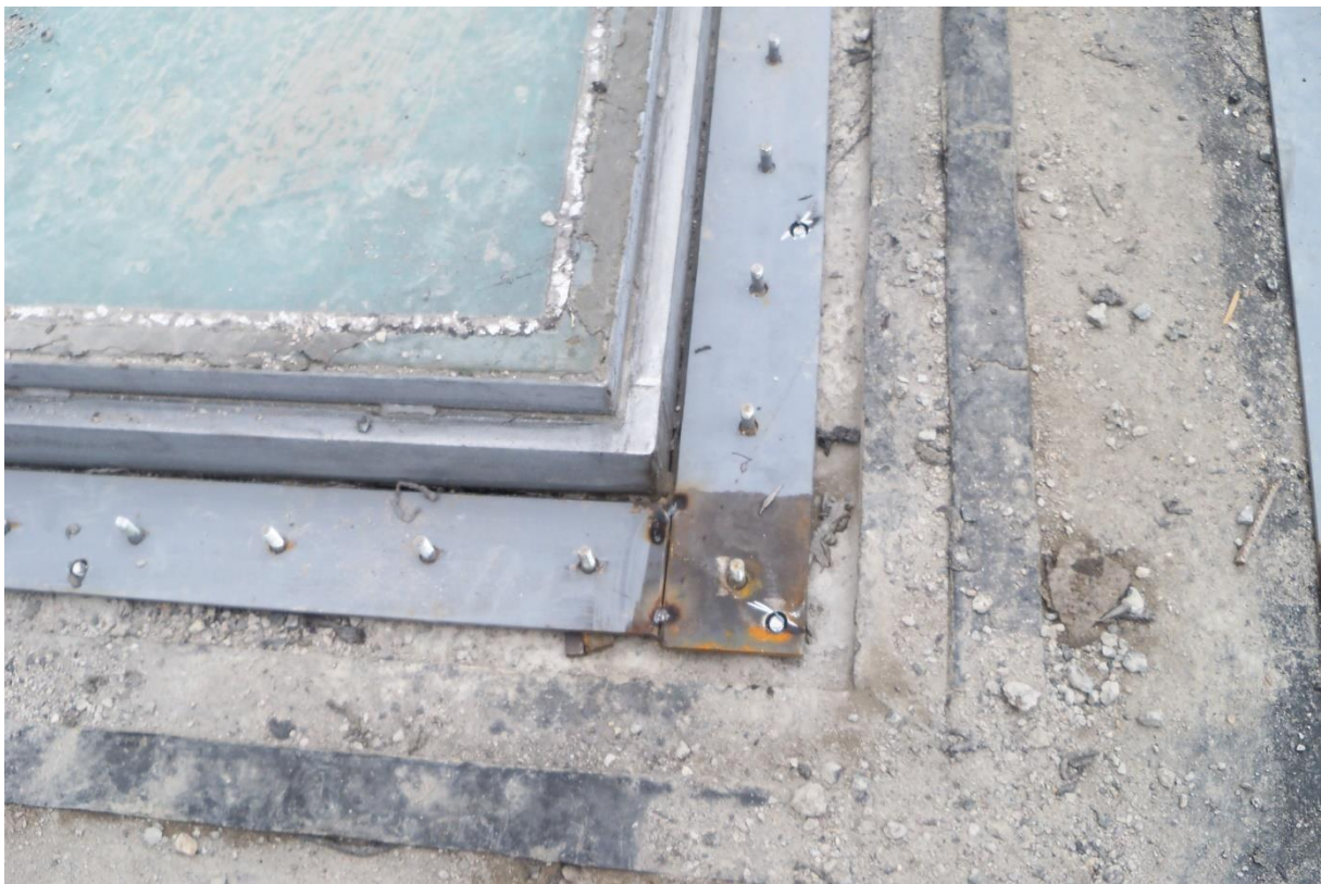
Obr. č. 11 – Volné příruby osazené na místo, kde bude proveden detail sevření izolace mezi volnou a pevnou přírubu
