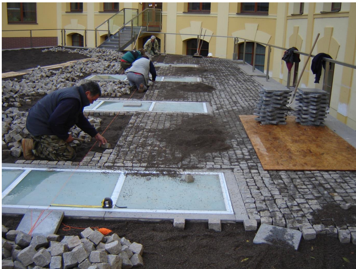
Obr. č. 30 – Provádění pochozí úpravy kolem světlíků
