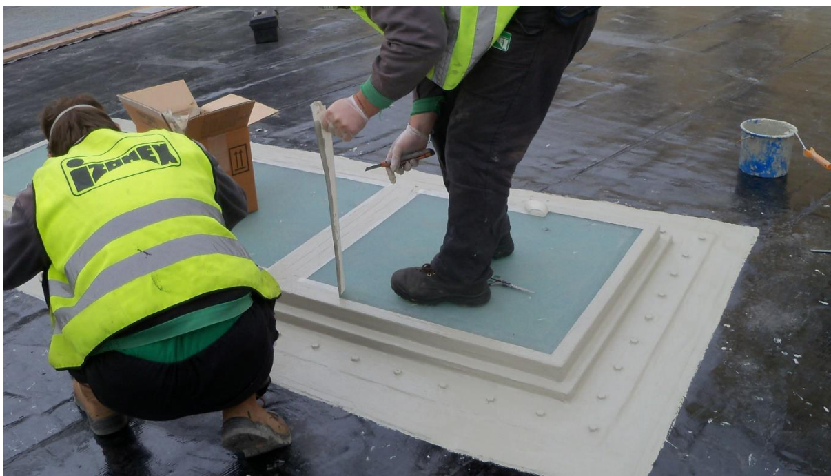
Obr. č. 20 – Po dokončení stěrkové izolace se strhávají lemovací pásy, které limitují provádění detailu ze stěrkové izolace, aby sklo zůstalo čisté. Ono odstraňovat Triflex z čehokoliv je práce pro vraha a prakticky to nejde
