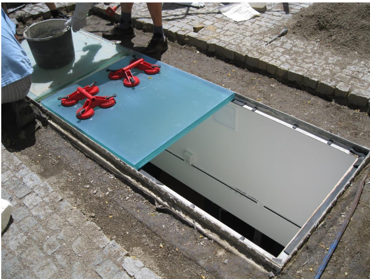
Obr. č. 6 – Osazování nových skel do světlíků
