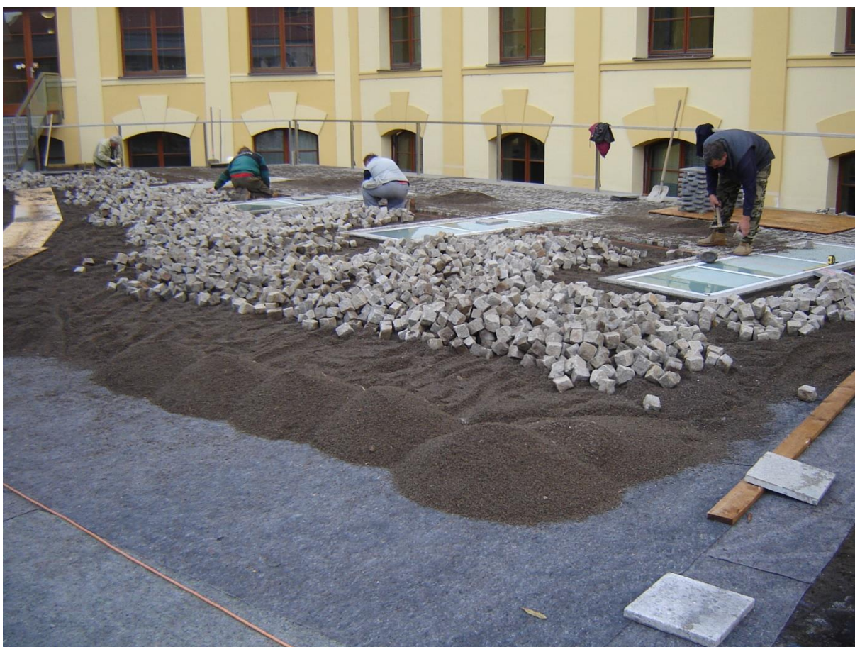
Obr. č. 29 – Provádění pochozí úpravy kolem světlíků
