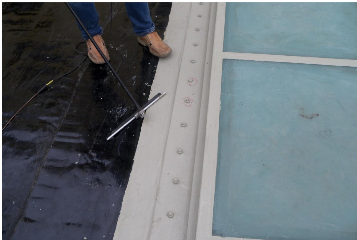
Obr. č. 26 – Jiskrová zkouška, provedená na hotovém izolačním povlaku
