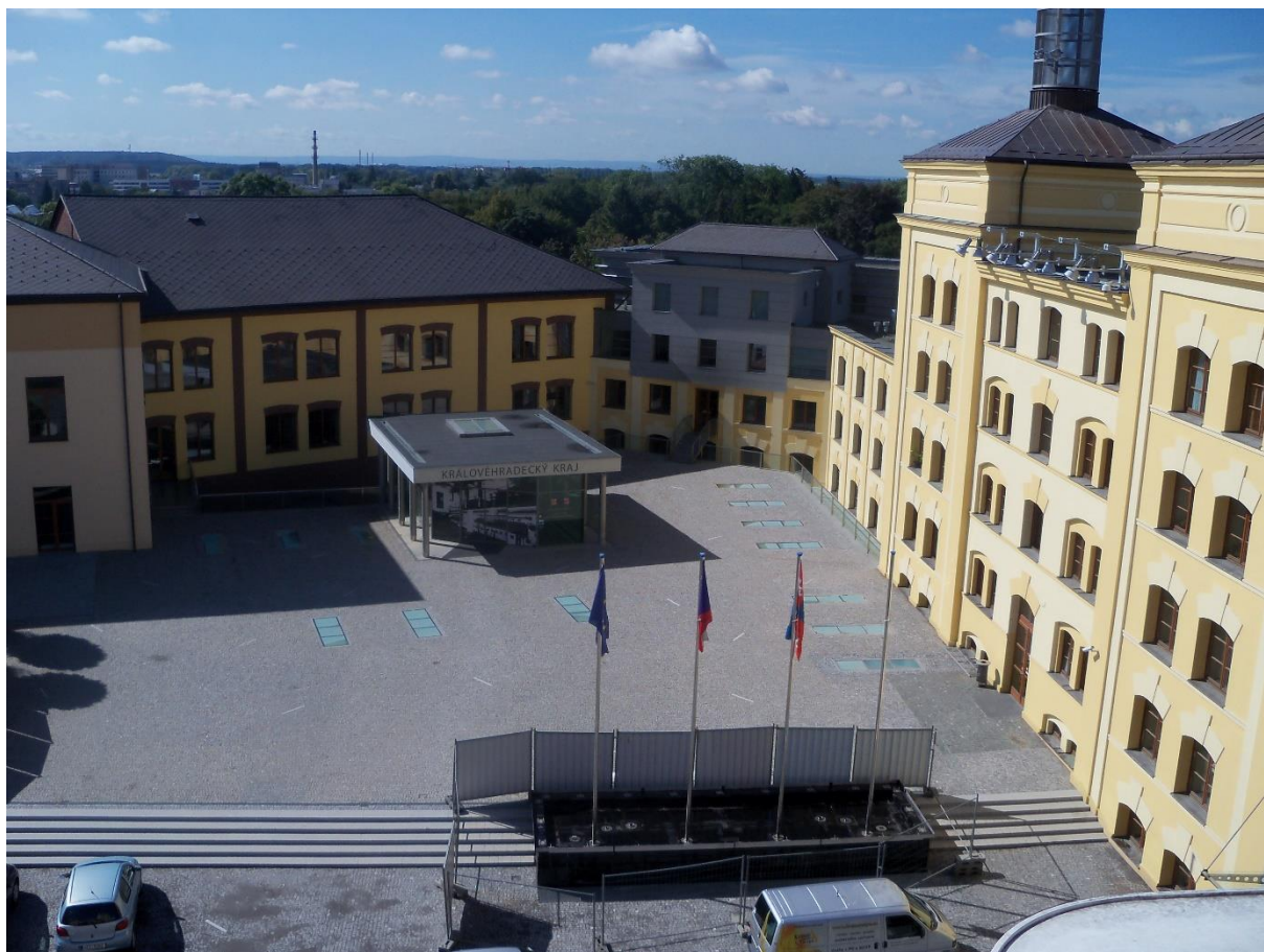
Obr. č. 1 – Celkový pohled na nádvoří, kde jsou patrná pochozí okna
