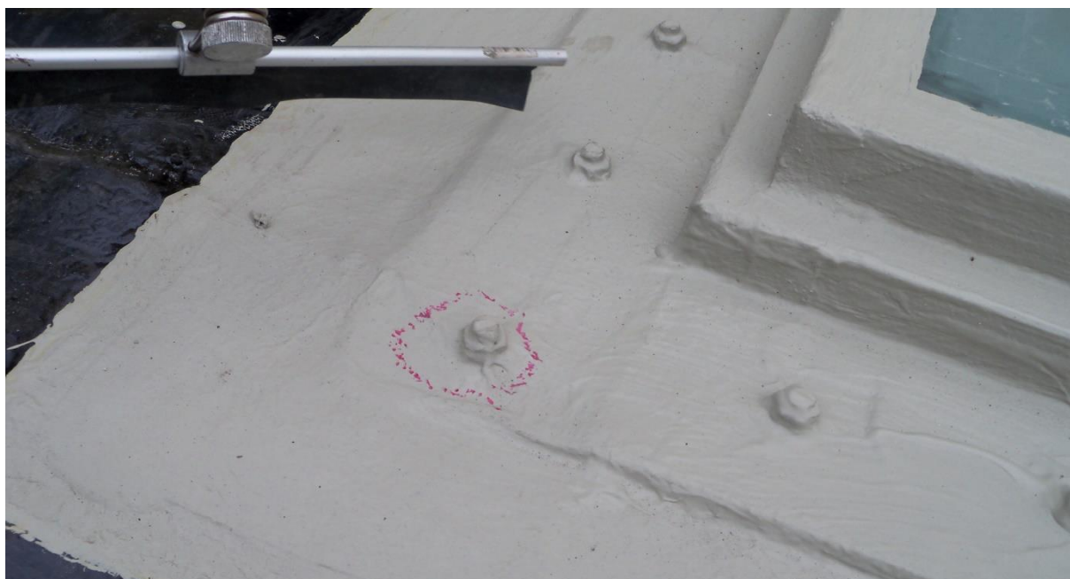
Obr. č. 27 – Jiskrová zkouška, která zde zjistila imperfekci v izolačním povlaku, která byla odstraněna další vrstvou stěrkové izolace
