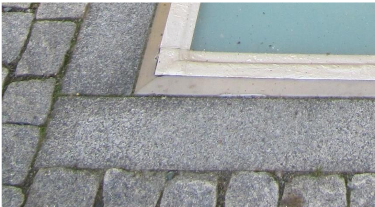
Obr. č. 3 – Asfaltovou samolepkou opracované prosklení v úrovni dlažby – což není izolace, která by zajistila vodotěsnost tohoto namáhaného konstrukčního detailu
