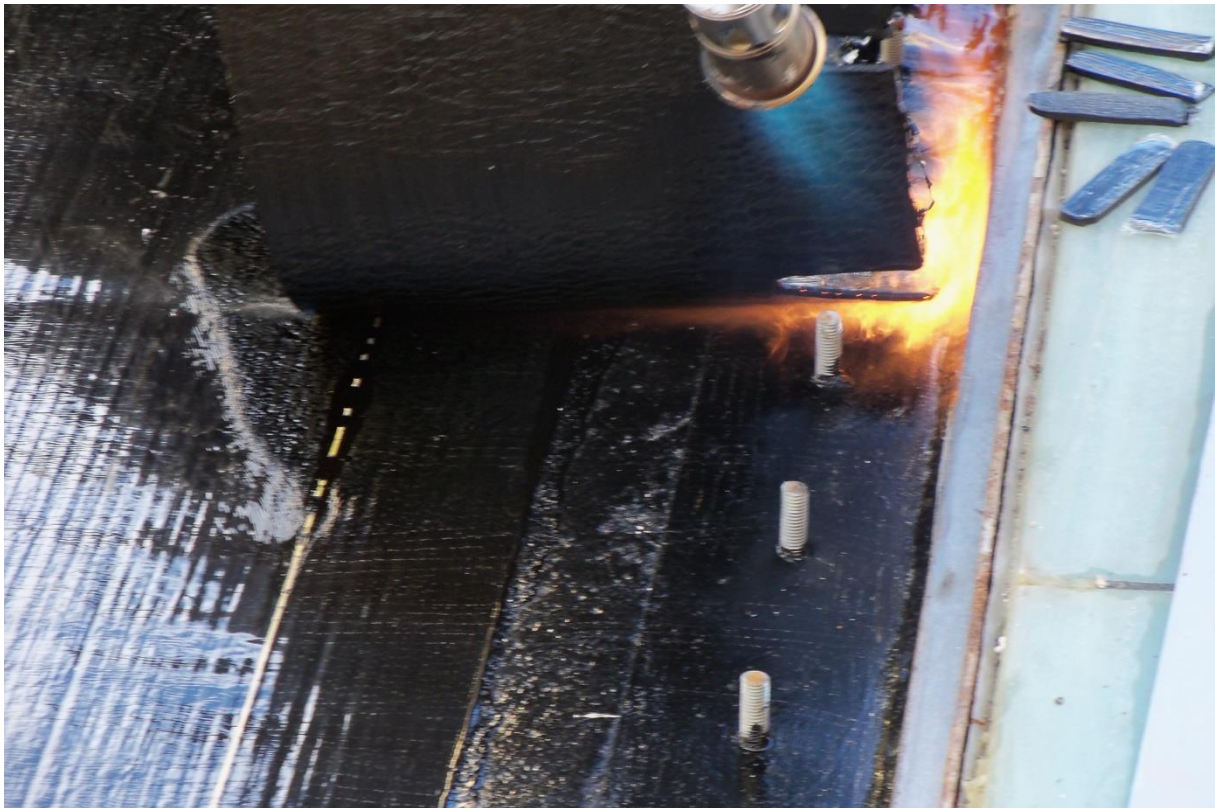
Obr. č. 14 – Navařování zesikujícího prouhu asfaltové hydroizolace pod volnou přírubu
