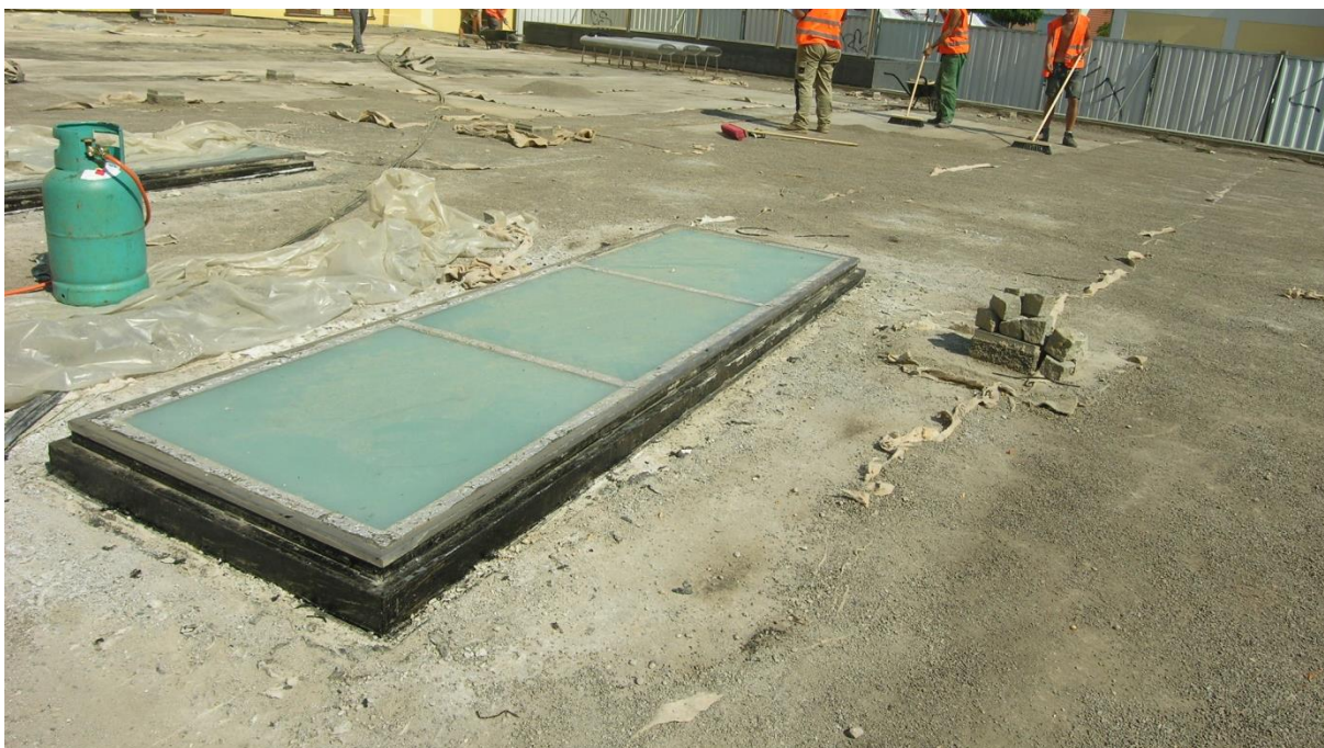
Obr. č. 5 – Odhalení světlíky s pochozím prosklením
