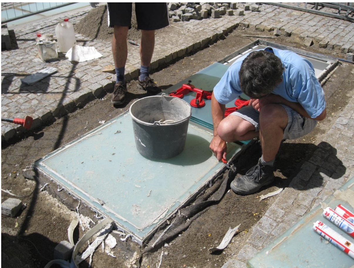
Obr. č. 4 – Archeologické zkoumání vodorovného prosklení, odstraňování původní izolace a pozdějších nánosů oprav
