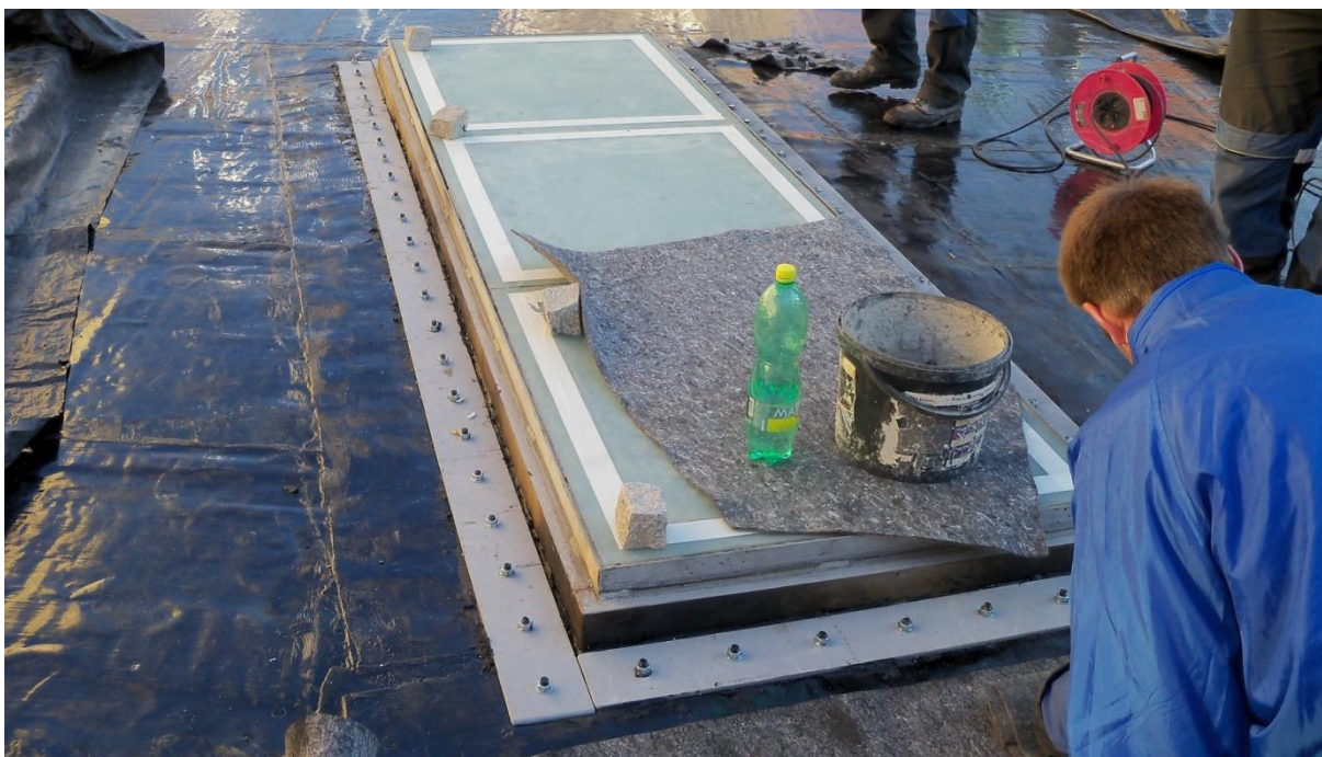
Obr. č. 18 – Konstrukční detail připravený pro provádění opravy stěrky PMMA
