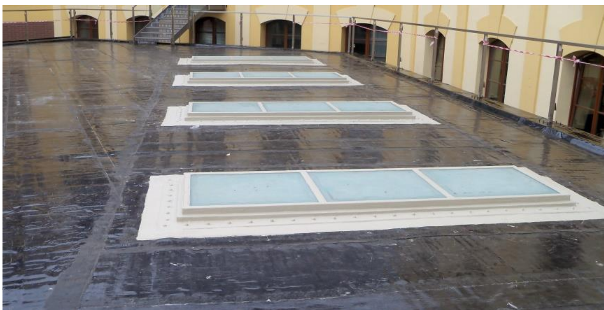
Obr. č. 21 – Celkový pohled na ukončený hydroizolační povlak na rámu prosklení
