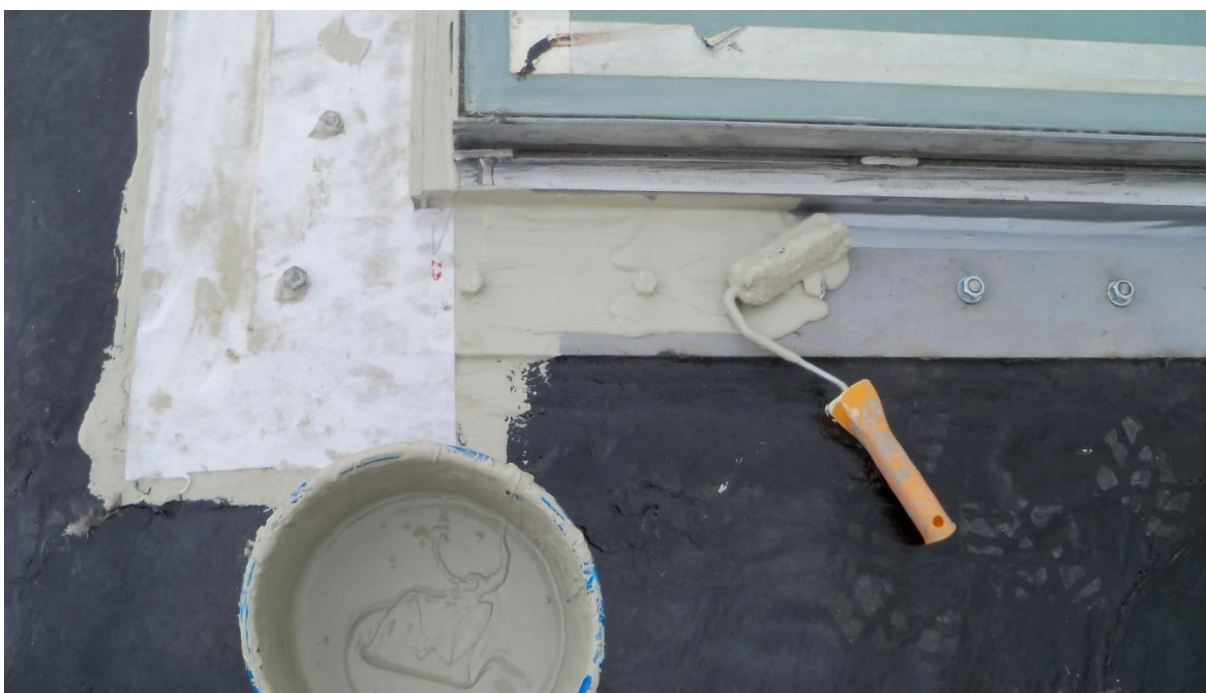
Obr. č. 19 – Provádění Triflexu (PMMA) jako další vrstvy hydroizolačního povlaku, která kryje v tomto případě ukončení asfaltové hydroizolace na rámu prosklení
