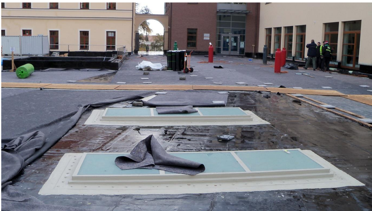
Obr. č. 28 – Provádění primárních ochranných vrstev
