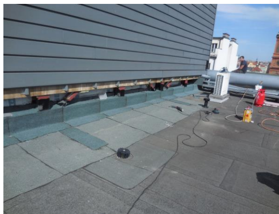
Obr. 8 Sanované napojení protihlukové stěny: a) sanovaný detail napojení stěny na střešní skladbu, b) foto stěny po sanaci.
