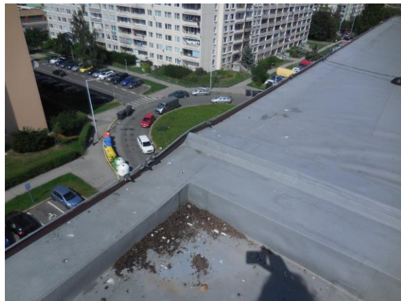
Obr. 7 Realizovaný detail dilatační atiky
