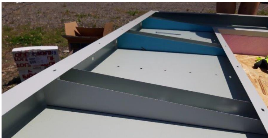
Obr. 6 - Záběr z ověřovací montáže prototypu - atika
