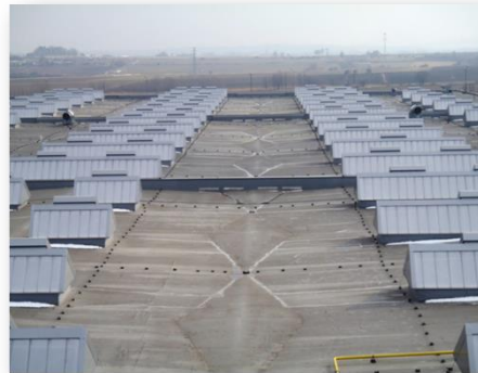
Správně vypádovaná střecha
