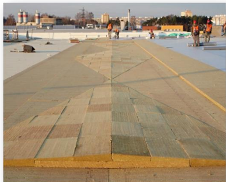
Spádování střechy pomocí systému ROCKFALL
