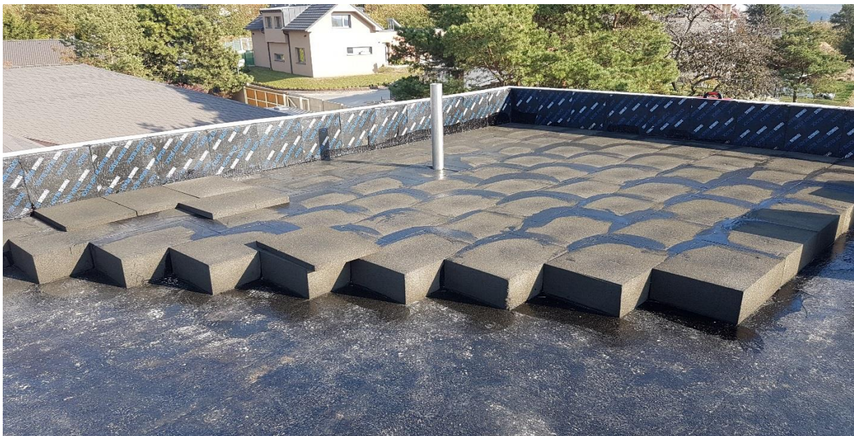
Kompaktně slepené desky FOAMGLAS® na betonové desce.
