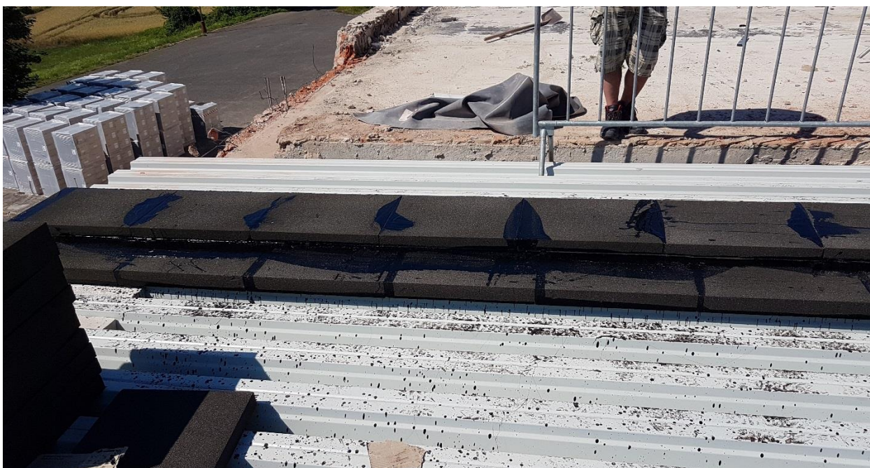
Dvouvrstvá kompaktní skladba FOAMGLAS® na trapézovém plechu.
