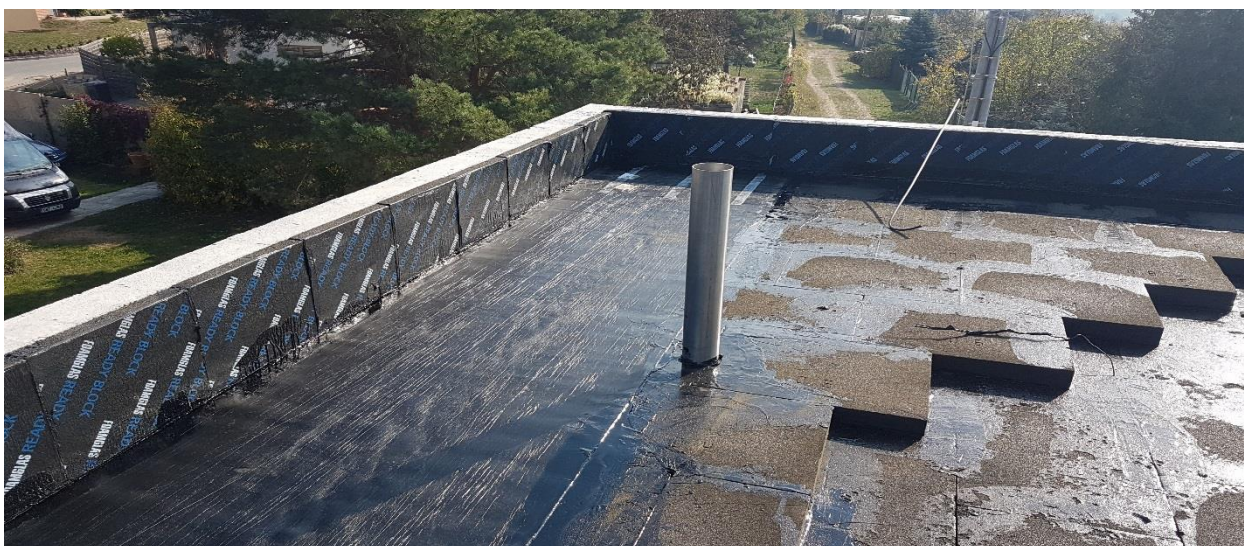
Kompaktně nalepená hydroizolace na spádových deskách FOAMGLAS®.
