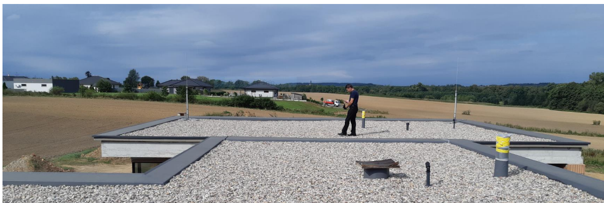
4) Úsekové měření senzorů na střeše bungalovu v Ústí nad Orlicí
