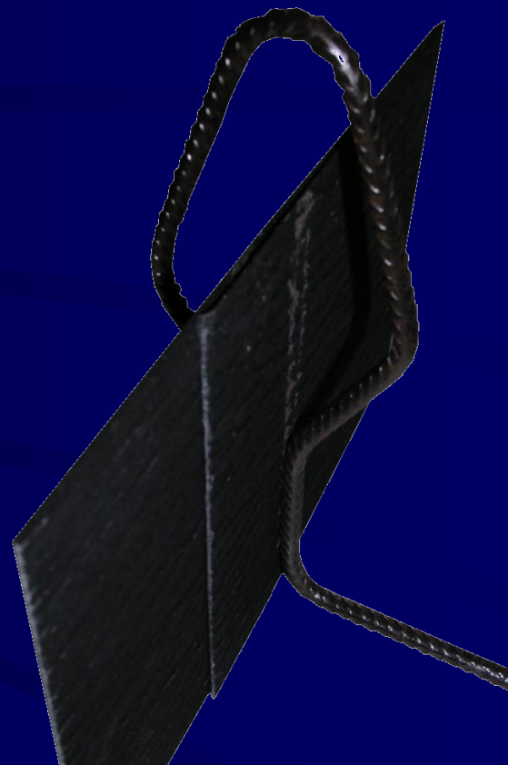
Spojení a zafixování plechu pomocí \Omega -spony
