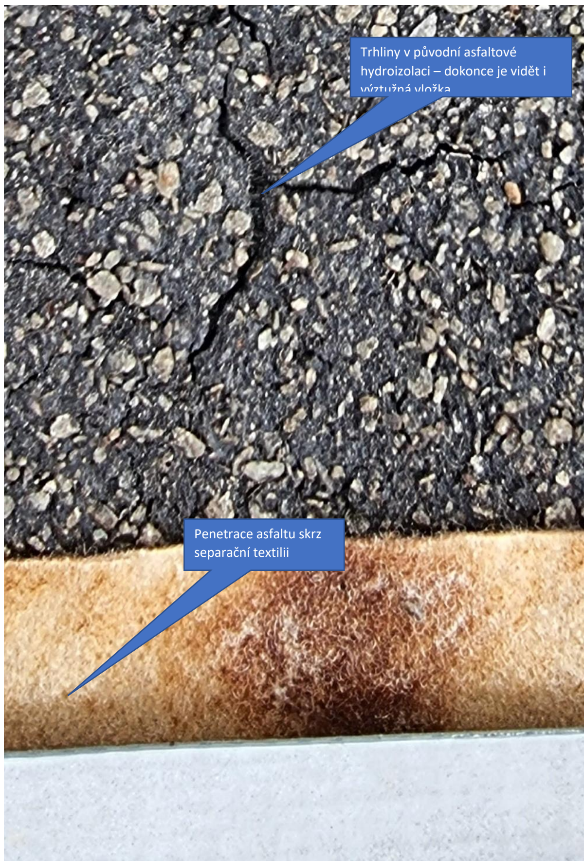
Obr. č. 171 – Detail předchozích obr. 309, ze kterého je patrná jednak nefunkčnost podkladního (původního) asfaltového hydroizolačního systému a současně penetrace separační fólie asfaltem z původního hydroizolačního systému.
