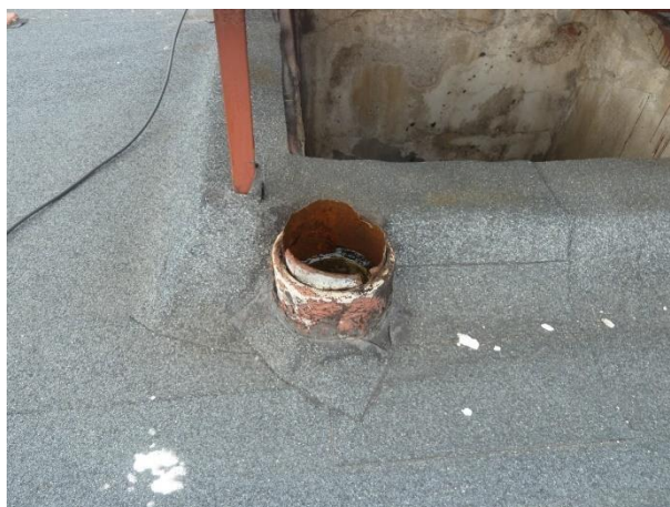
Obr. č. 229 – Soubor špatně provedených detailů
