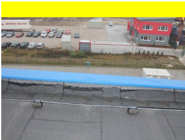
Obr. č. 190 – Sjíždění hydroizolace z atiky
