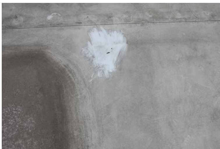
Obr. č. 111 – Propálená fólie po dopadu zábavní pyrotechniky
