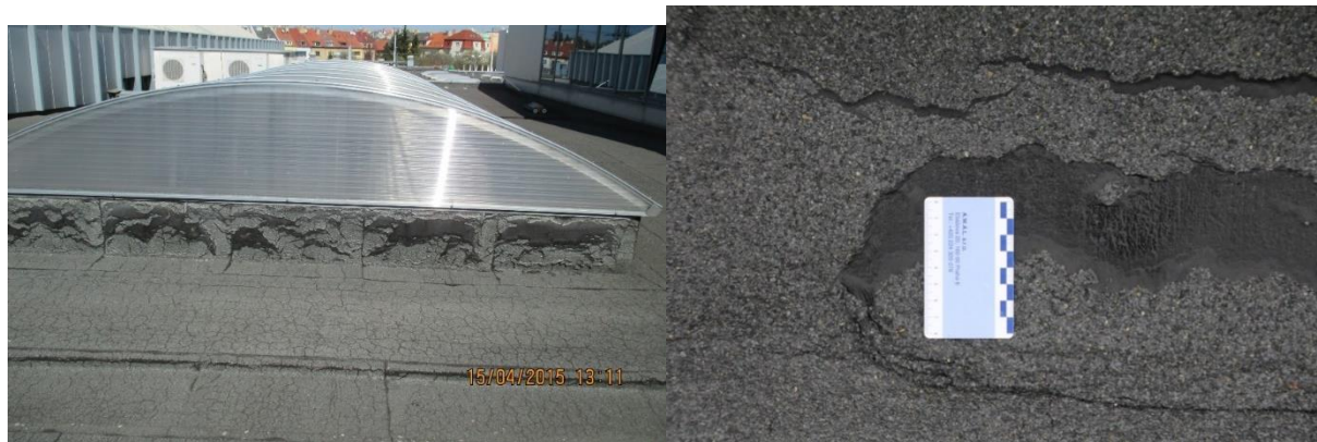
Obr. č. 187 – Sjíždění asfaltové hydroizolace ze svislé plochy světlíku
