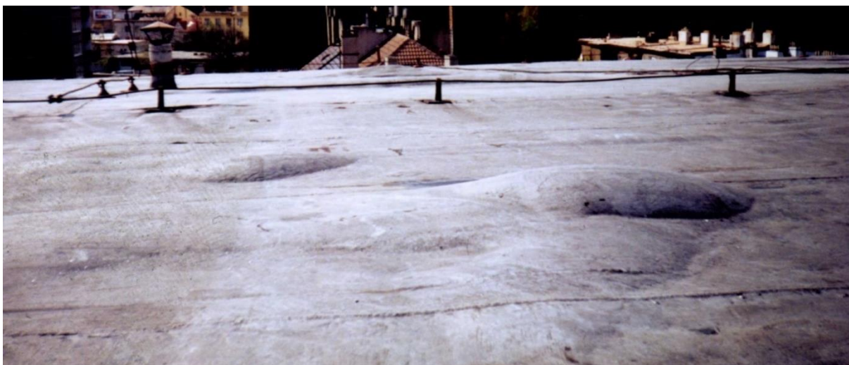
Obr. č. 24 - Boule signalizující pasivní bilanci zkondenzované a vypařené vodní páry
