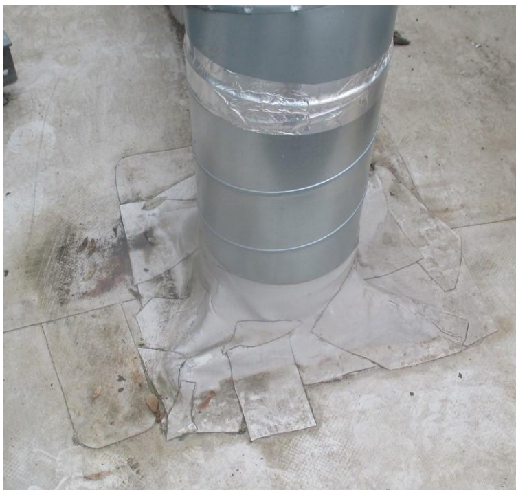
Obr. č. 146 – Prostup opracovaný „tisíci“ kousky fólie určitě není zcela funkční (navíc je strašně ošklivý)
