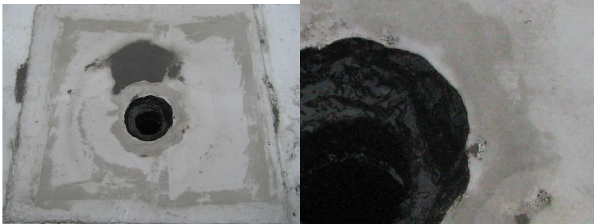
Obr. č. 167 – Opracování vpusti asfaltem a do něj je vlepena hydroizolační fólie PVC
