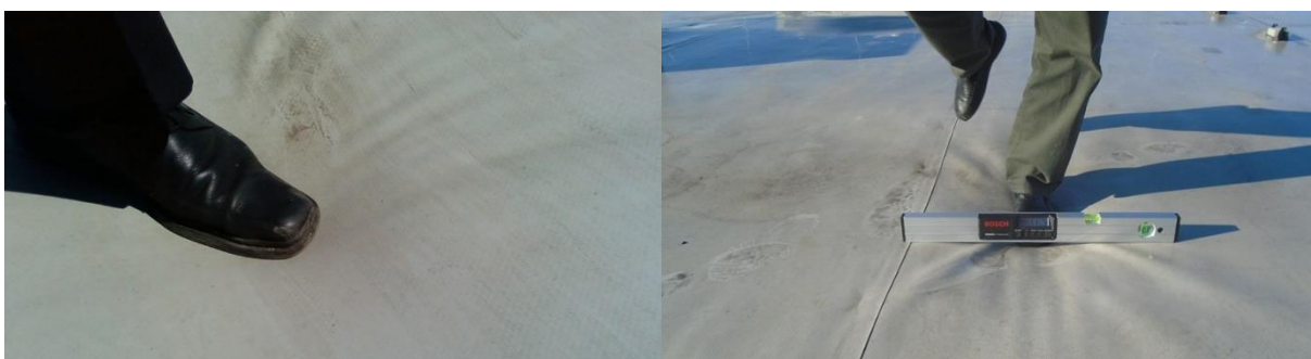
Obr. č. 61 – Prošlápaná tepelná izolace na bázi minerálních vláken
