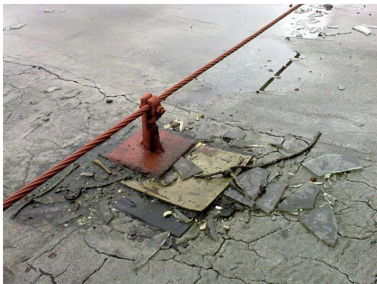
Obr. č. 203 – Výskyt skla na hydroizolačním povlaku nesvědčí o správné údržbě
