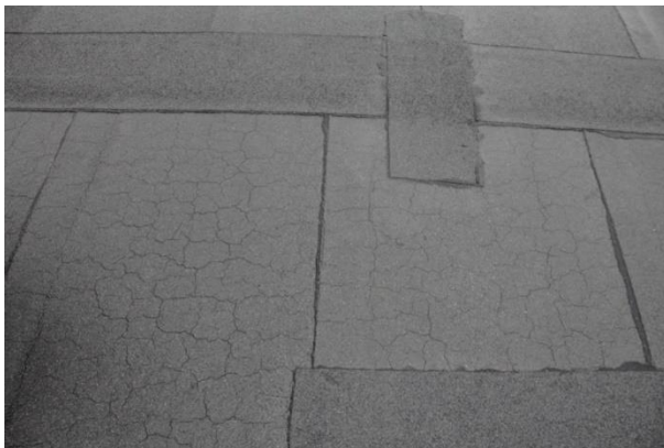
Obr. 49 – Krokodýling v ploše s přepáskovaným spojem
