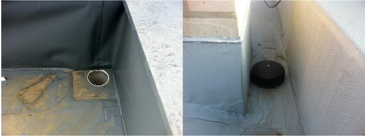
Obr. č. 169 – Naprosto nevhodné umístění vpusti
