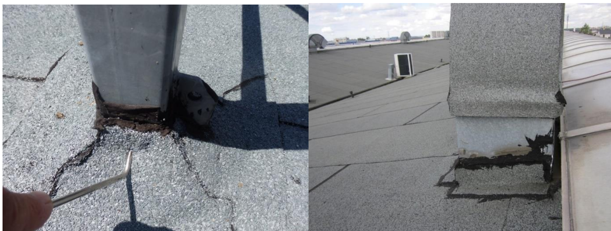
Obr. č. 222 – Řádně neopracovaný čtvercový prostup, u obrázku vpravo je i neopracovatelný, protože mezi světlík a vzduchotechniku se nic nevejde
