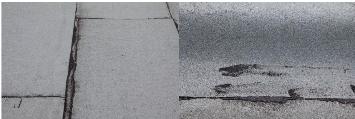
Obr. č. 213 – Nepřesné srovnání hydroizolačních pasů před navařováním
