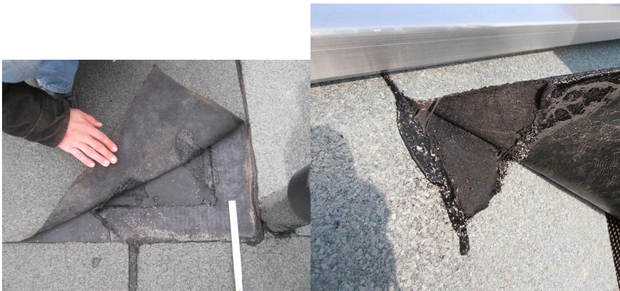
Obr. č. 183 – Delaminace hydroizolačního materiálu – je patrná část asfaltového pásu a oddělená vrchní část
