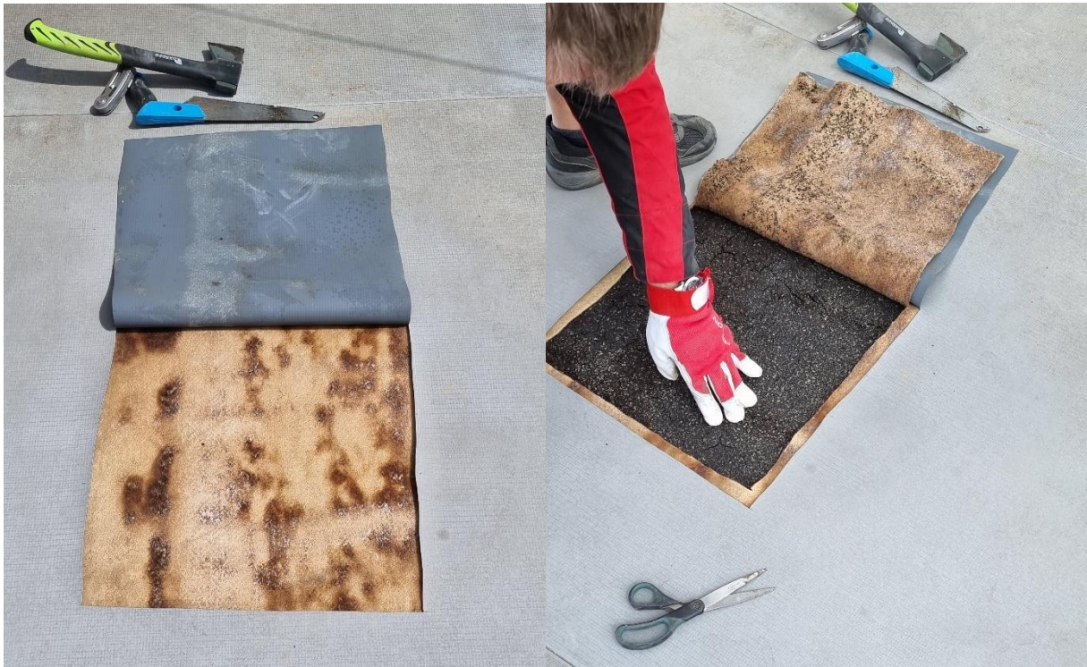
Obr. č. 170 – Fólie a asfalty jsou neslučitelné a to i přes separační textilii
