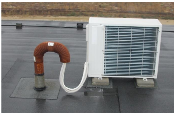
Obr. č. 238 – Improvizace na téma kabelový prostup s použitím kouřovodů
