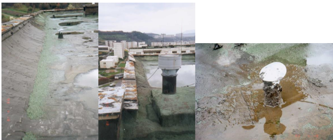
Obr. č. 74 – Vložení raritní stěrková asfaltové hydroizolace se vsypem barveným kamenivem
