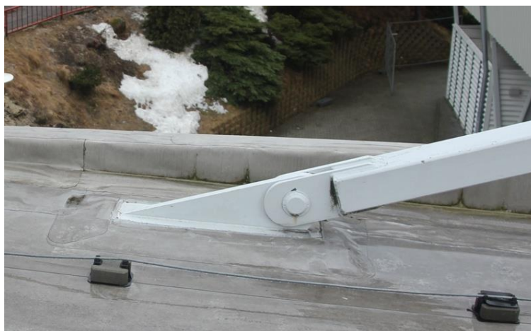
Obr. č. 162 – Ukončení hydroizolačního povlaku na táhlu
