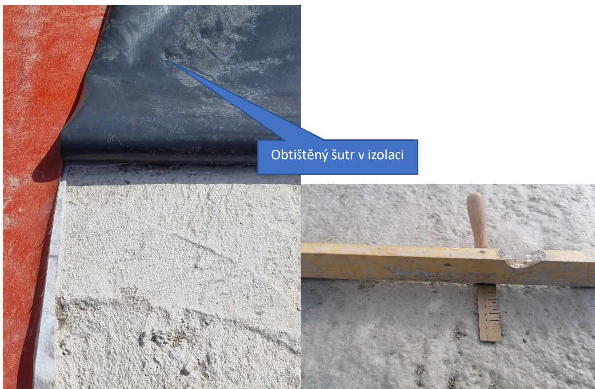
Obr. č. 55 – Hrubost resp. lokální nerovnost podkladu otištěná do negativní strany hydroizolace
