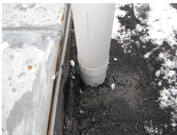
Obr. č. 231 – Prostup tvrzeného PVC asfaltovým hydroizolačním povlakem - materiály, které se nemají rády
