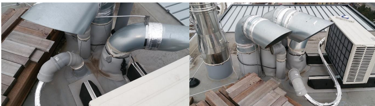
Obr. č. 9 – Nahromadění konstrukčních detailů, které jsou celkově neopracovatelné, může být i na rodinném domě
