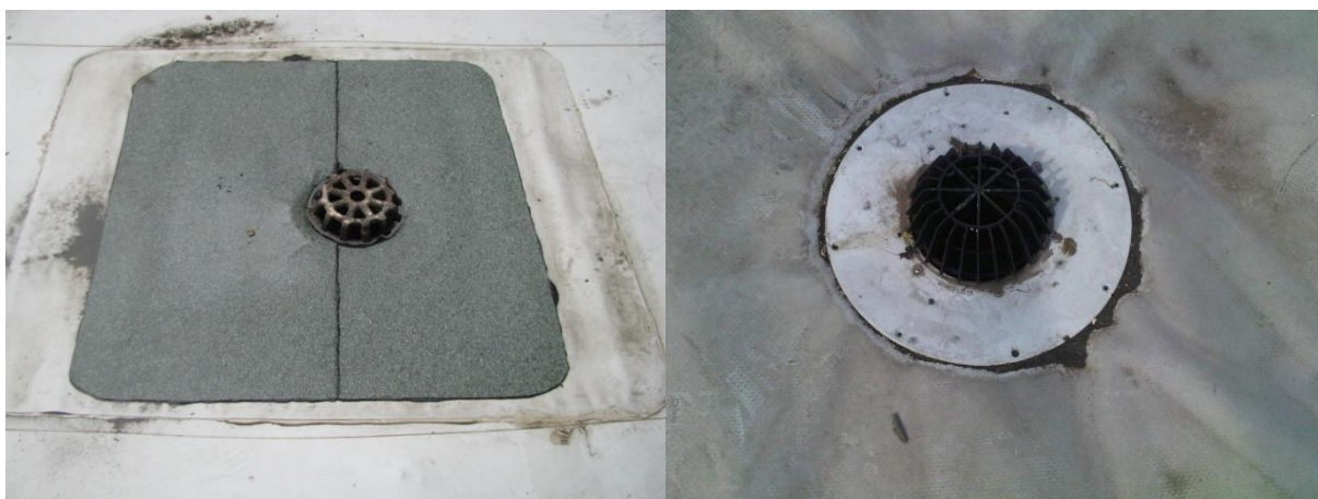
Obr. č. 168 – Příklad podtmelená asfaltem
