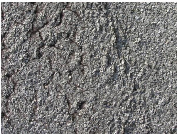
Obr. č. 191 – Krokodýling pod hydrofobizovaným posypem
