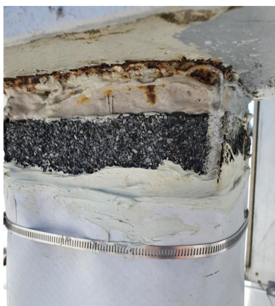
Obr. č. 176 – Opracování prostupu fólií přes původní asfaltovou hydroizolaci
