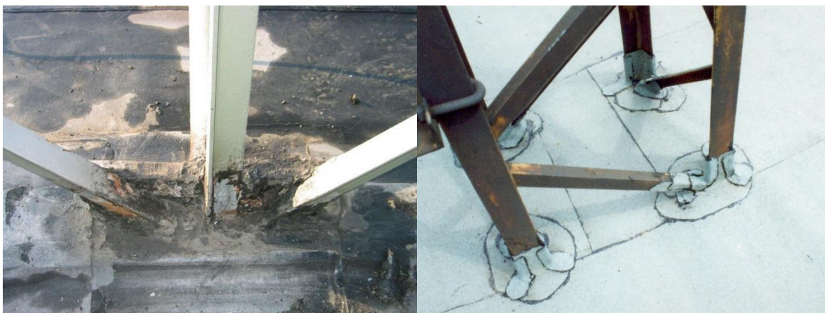
Obr. č. 249 – Pohled na standardními postupy neopracovatelný konstrukční detail (zde je nutné použít stěrkové izolace)
