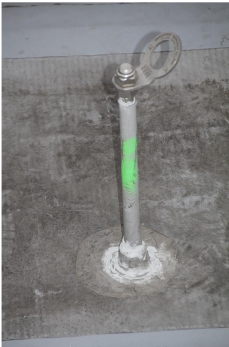
Obr. č. 151 – Opracování tyčového prostupu bezpečnostního prvku – fólie je na tělo prvku pouze dotmelena, a to ještě v minimální výši
