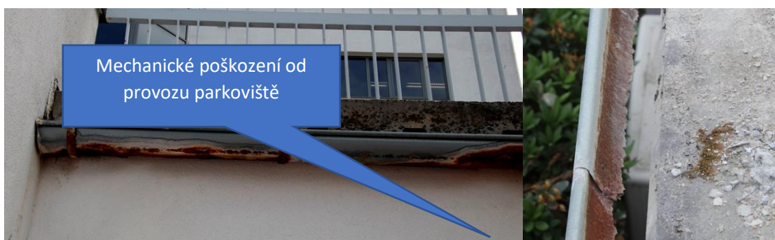
Obr. č. 51 – Vnější žlaby – stav před rekonstrukcí
