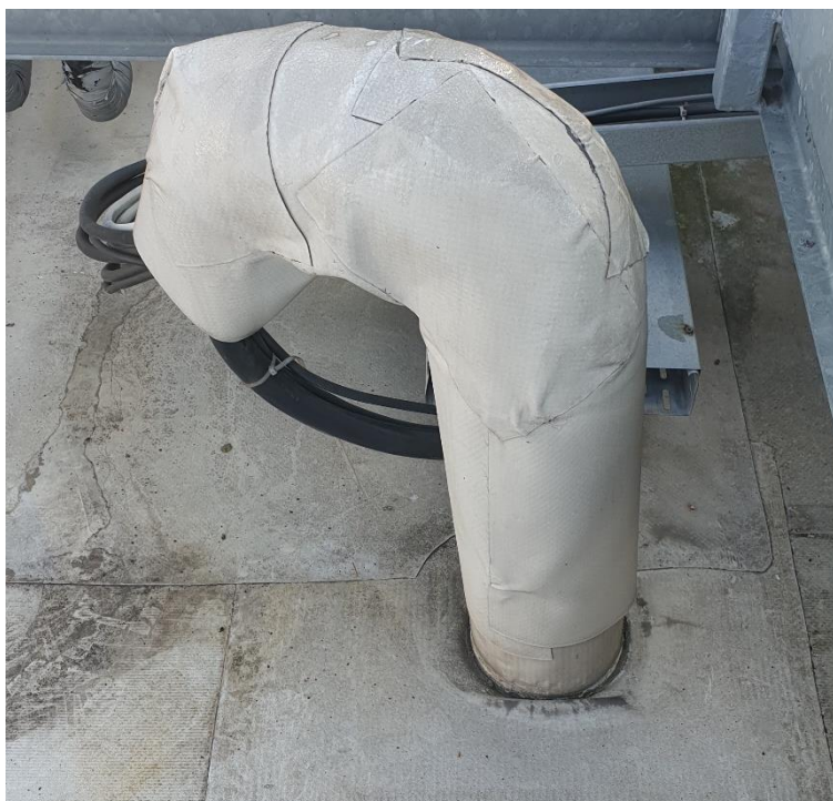
Obr. č. 157 – Kabelový prostup vytvořený z fólie
