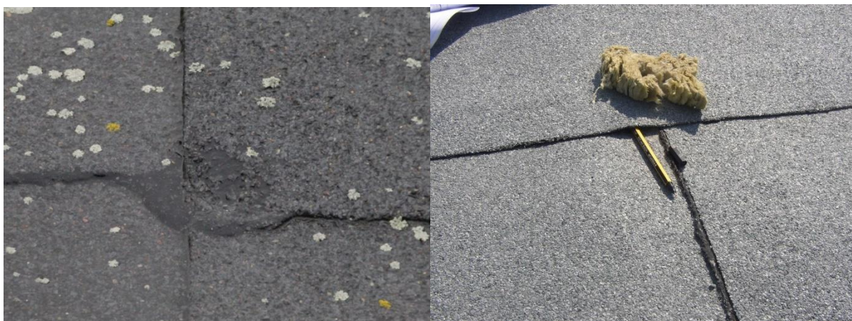
Obr. č. 206 – Křížový spoj, stejný jako na předchozím obrázku, ale navíc s převažným pásem
