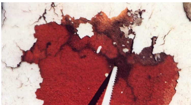
Obr. č. 67 – Stříkaný polyuretan s nevytuzenou akrylátovou hydroizolační stěrkou
