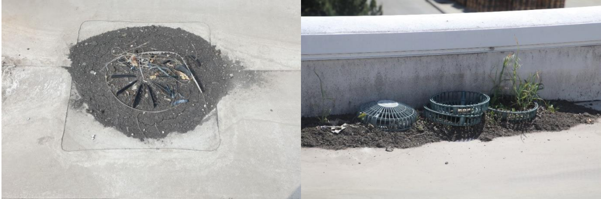
Obr. č. 252 – Vpust zanesená nánosy spadů svědčí o problematické údržbě
