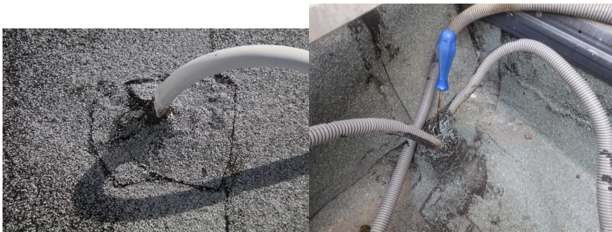
Obr. č. 244 – Prostup chráničky není korektním řešením
