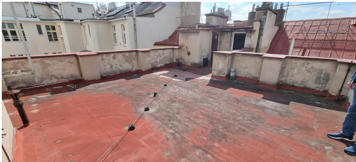
Obr. č. 64 – Historické řešení hydroizolací pomocí akrylátových stěrek
