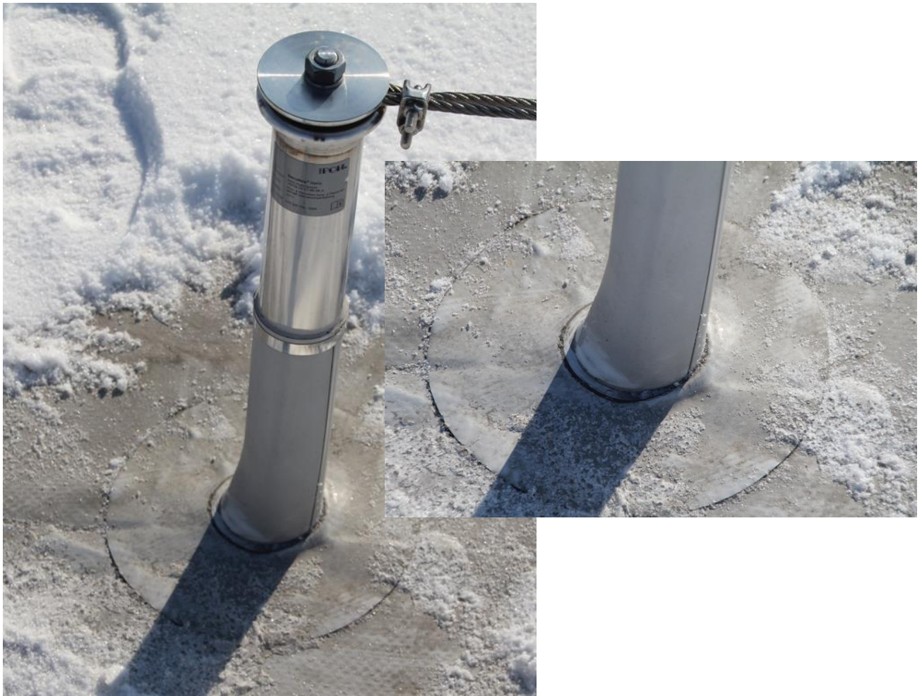
Obr. č. 152 – Napojení bezpečnostního prvku na hydroizolační povlak
