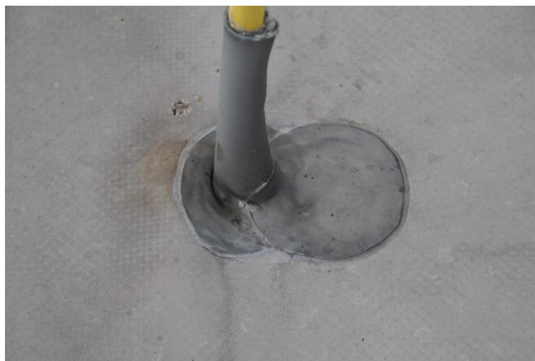
Obr. č. 153 – Opracování tyčového prostupu
