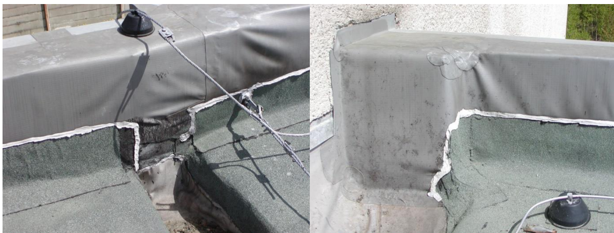
Obr. č. 174 – Sanace původního fóliového hydroizolačního systému modifikovaným asfaltem
