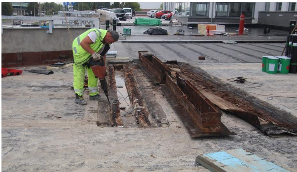
Obr. č. 45 – Vybourávání zkorodovaných liniových odvodňovacích žlabů
