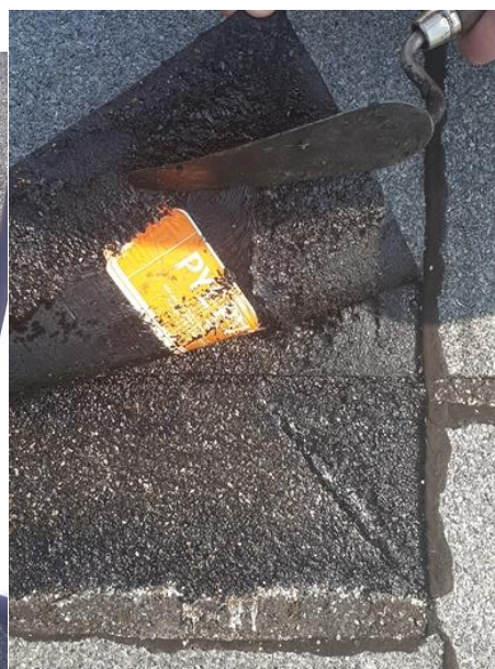
Obr. č. 211 – Snímek zachycuje nespálenou „spalnou“ fólii, tzn. že pás byl volně položen a nebyl s podkladem vůbec spojen
