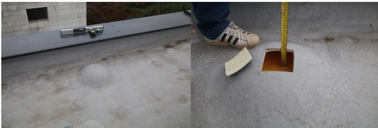
Obr. č. 72 – Polyuretanové stříkané izolace s povrchovou polyuretanovou nevyztuženou stěrkou (nátěrem)
