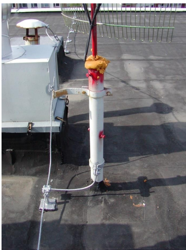
Obr. č. 239 - Bizardní kabelový prostup, který je dotěsněn pouze montážní PUR pěnou
