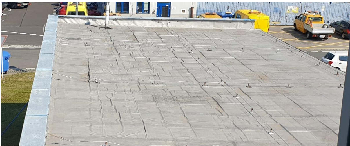
Obr. č. 60 – Pohyby podkladu, které se prokreslí do hydroizolace
