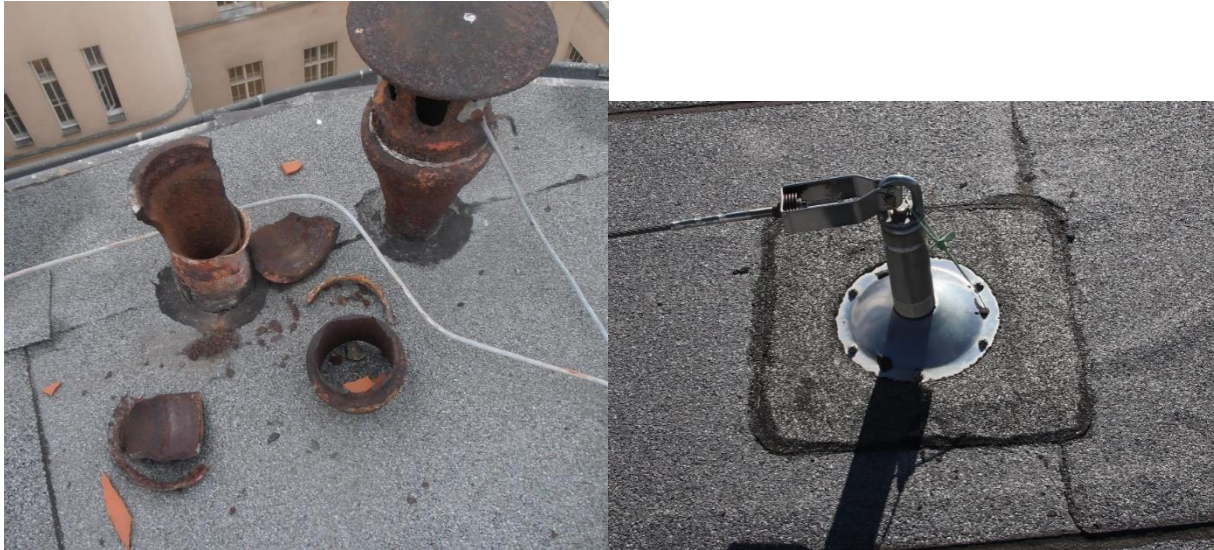
Obr. č. 232 – Opracování litinových kanalizačních tvarovek
