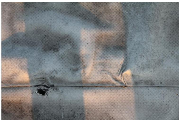
Obr. č. 119 – Příklad nekvalitního svařování, resp. převařování hydroizolační fólie PVC
