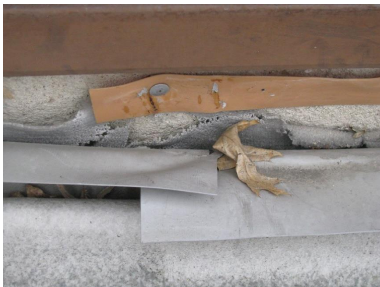
Obr. č. 132 – Vytažení na svislou konstrukci a ukončení bez řádného připojení ke svislé konstrukci
