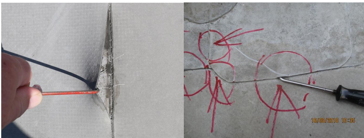
Obr. č. 122 – Nekvalitní svar, resp. označení děr ve svarech hydroizolace
