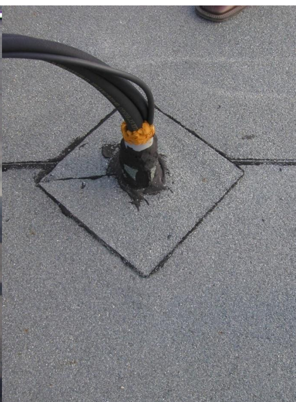
Obr. č. 239 - Bizardní kabelový prostup, který je dotěsněn pouze montážní PUR pěnou
