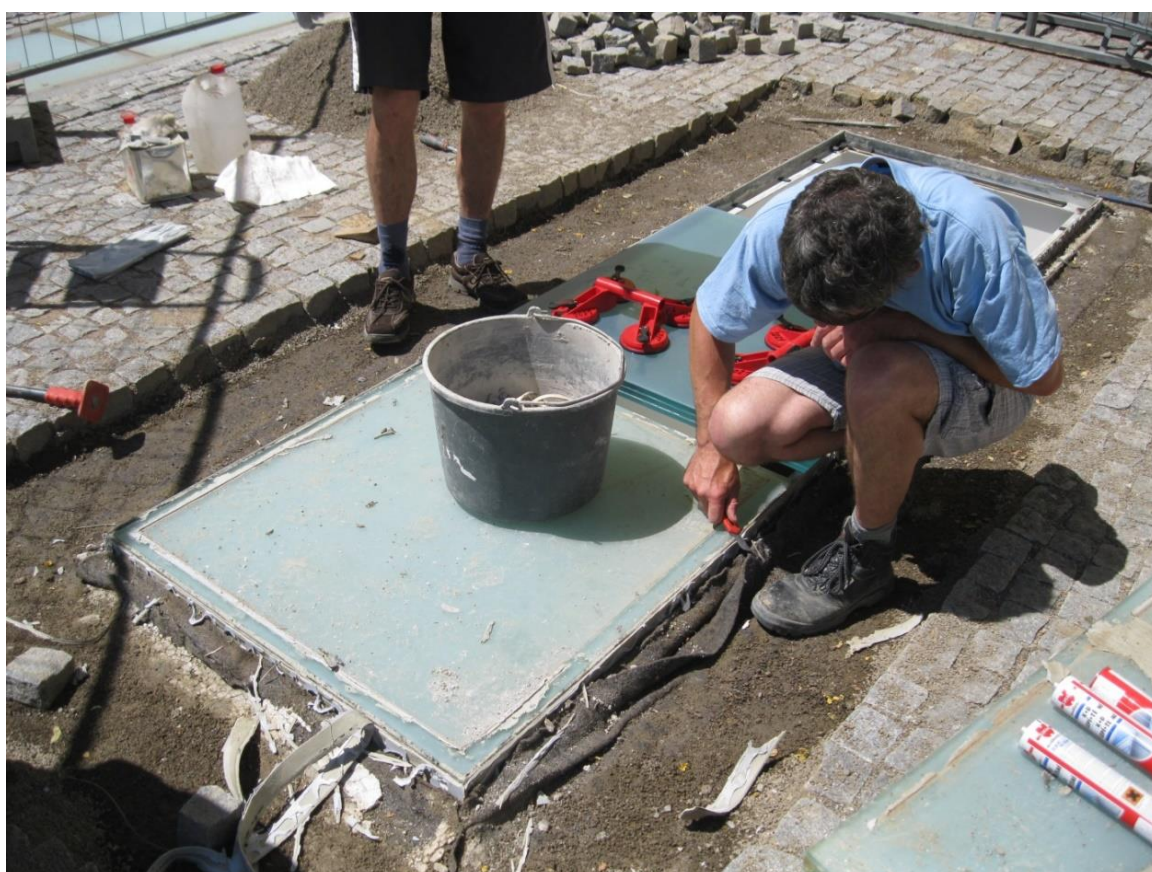
Obr. č. 4 – Obr. č. Archeologické zkoumání vodorovného prosklení, odstraňování původní izolace a pozdějších nánosů oprav
