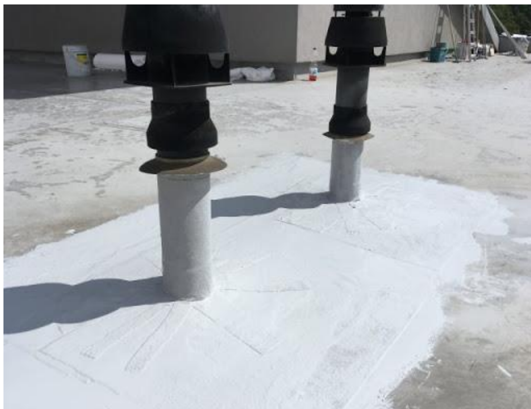
Obr. č. 3 – Provedení detailu napojení izolace odvětrávacího potrubí pomocí geotextilie weberdry fabric
