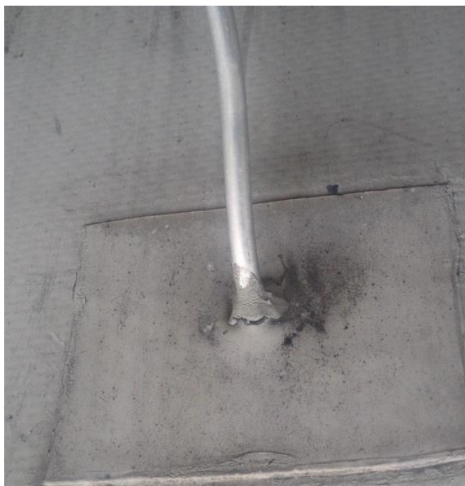
Obr. 3 – Opracování prostupu jde i bez detailové folie
