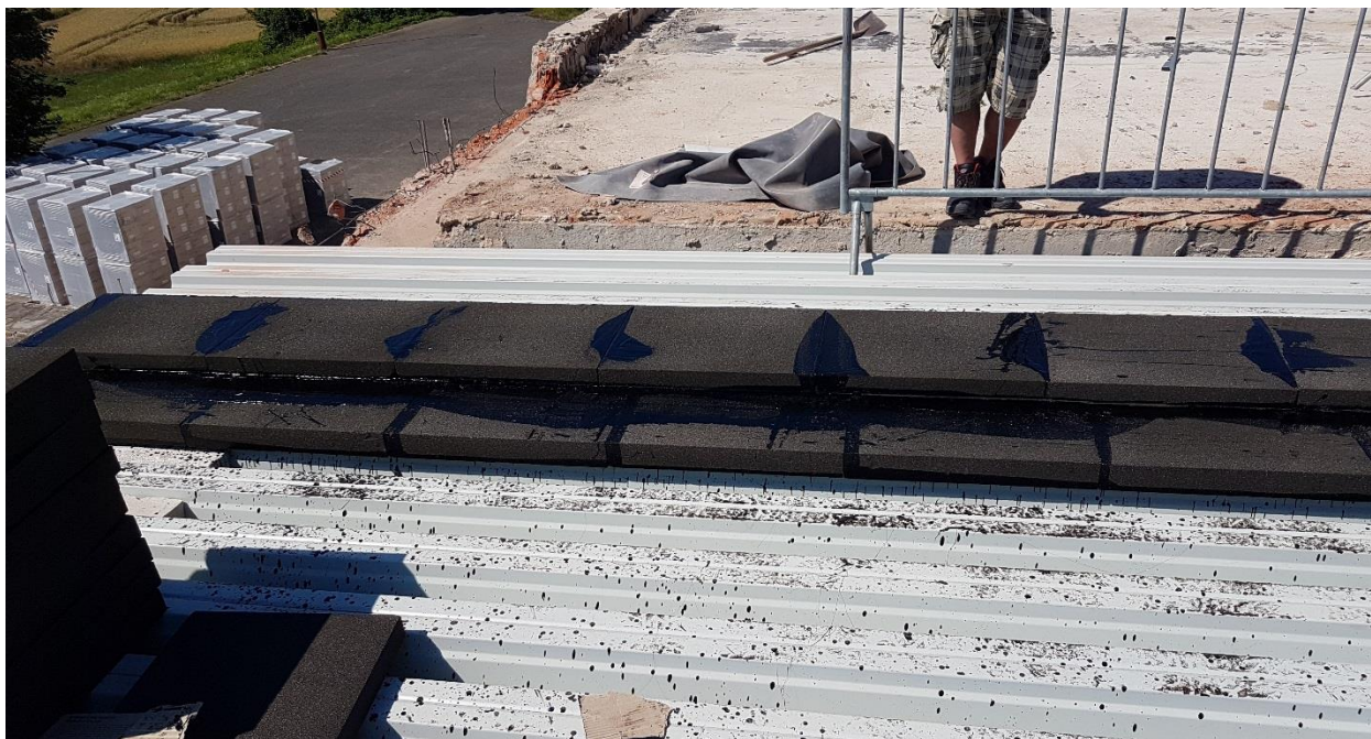
Dvouvrstvá kompaktní skladba FOAMGLAS® na trapézovém plechu.
