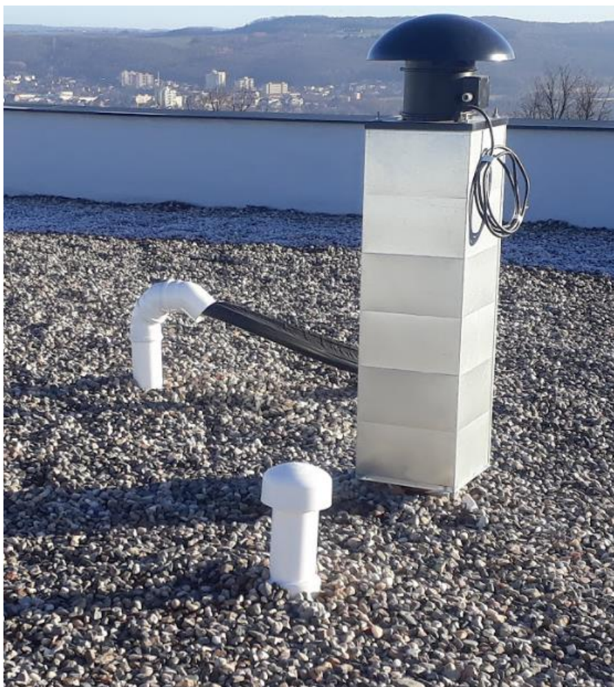
Obr. 7 - Prefabrikované prvky (TOPWET TWP a TWOP)
