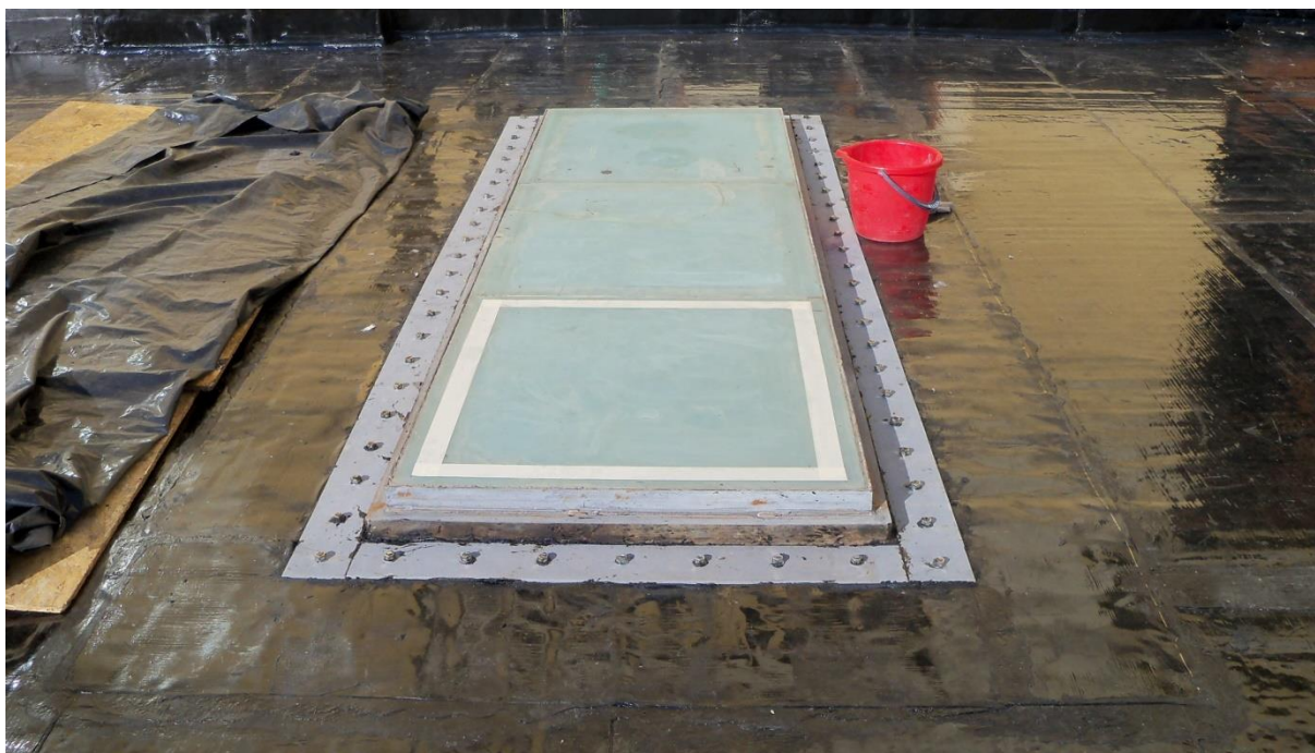
Obr. č. 16 – Opracování celého prosklení včetně vlné a již osazené volné příruby
