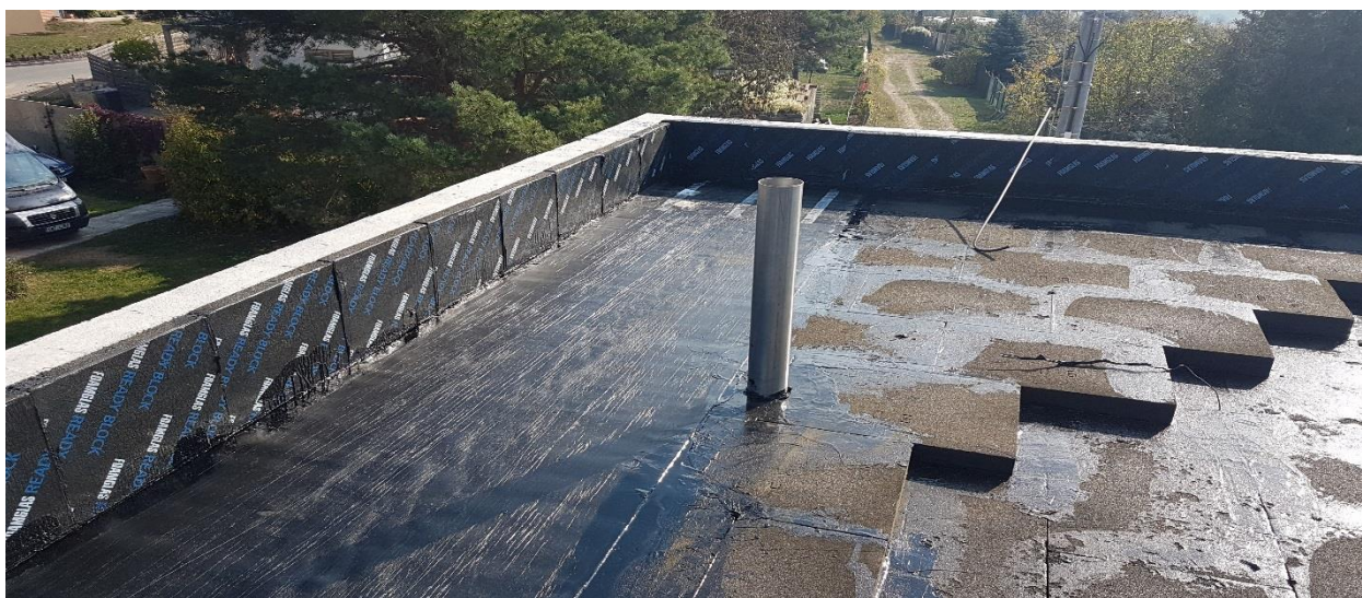
Kompaktně nalepená hydroizolace na spádových deskách FOAMGLAS®.
