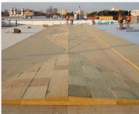
Spádování střechy pomocí systému ROCKFALL
