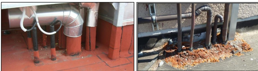
Obr.č.1 – Příklad zpracování kruhových prostupů. Zdroj. [2].
