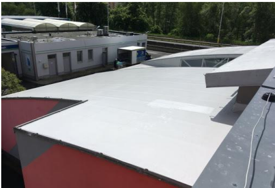
Obr. č. 5 – Dokončená rekonstrukce střechy, 2vrstvy weberdry pur seal+geotextilie weberdry fabric.
