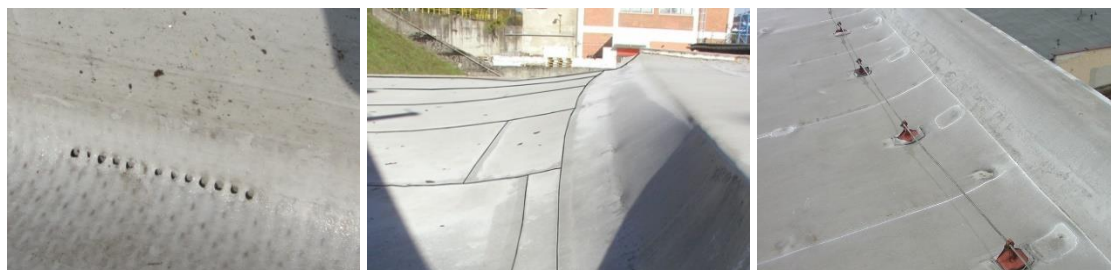
Obr. 10: Díry ve fólii po odtržení fólie od patečního L-profilu a odstrašující případ vzniku „trampolíny“
