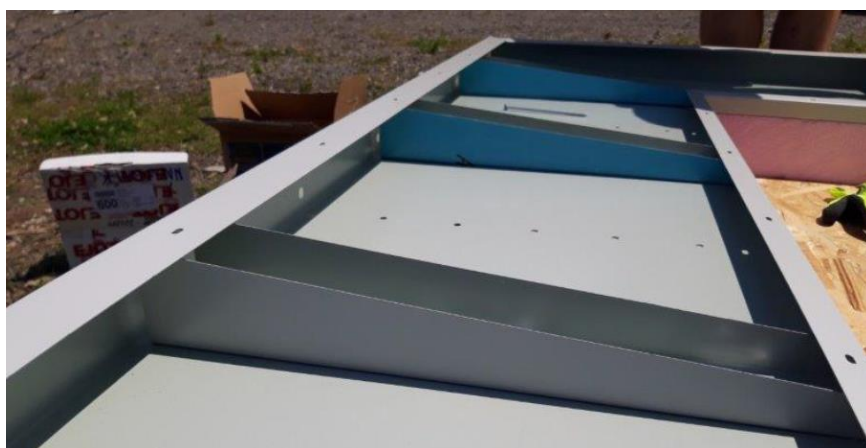
Obr. 6 - Záběr z ověřovací montáže prototypu - atika
