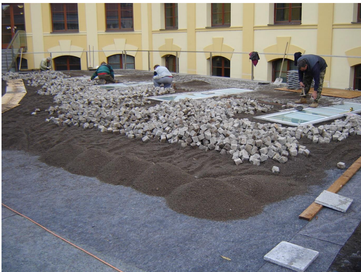
Obr. č. 29 – Provádění pochozí úpravy kolem světlíků
