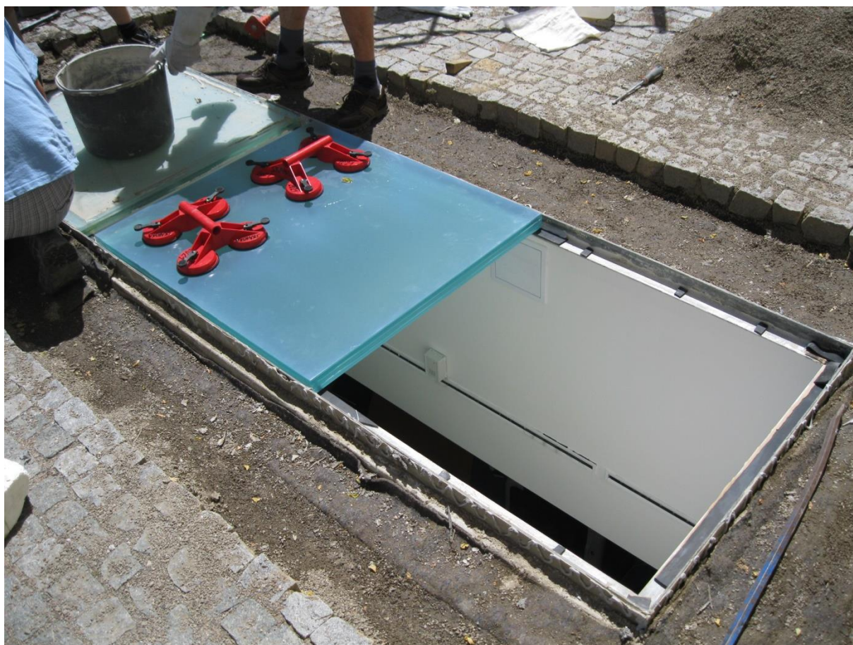
Obr. č. 6 – Osazování nových skel do světlíků
