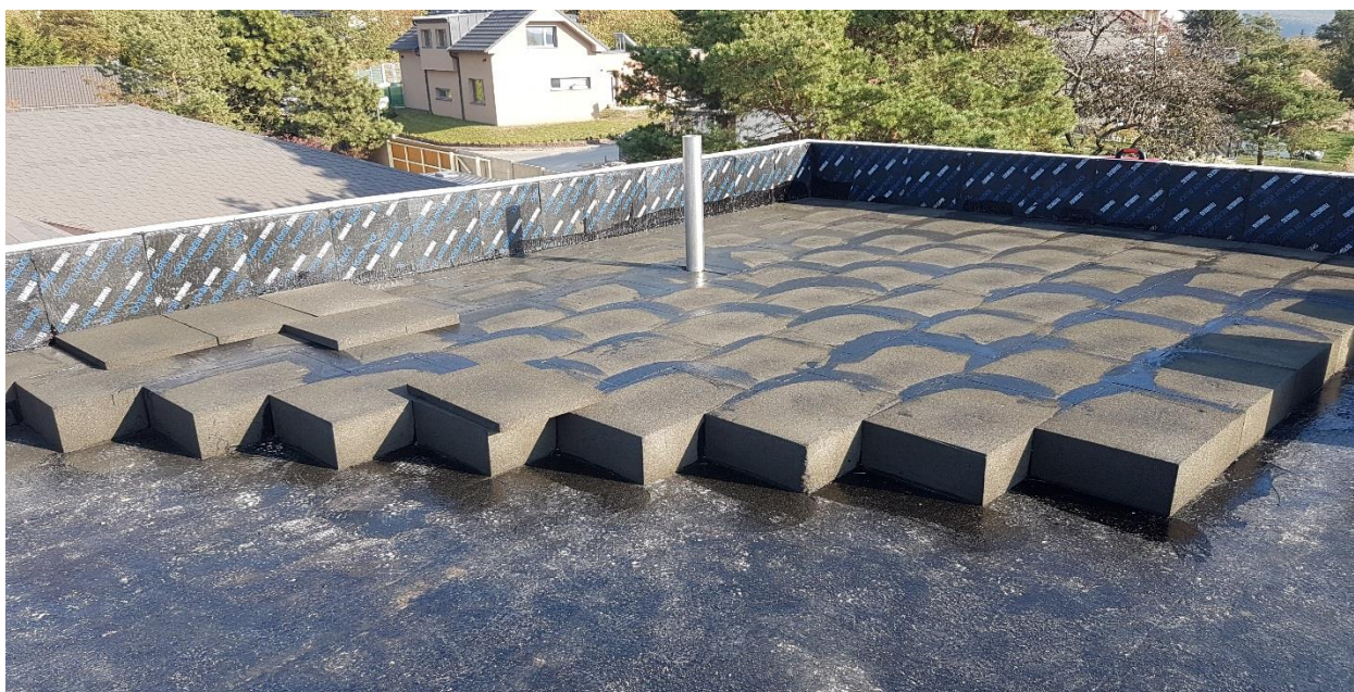
Kompaktně slepené desky FOAMGLAS® na betonové desce.
