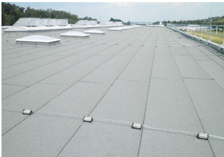
Obr. Asfaltové pásy položené správně
