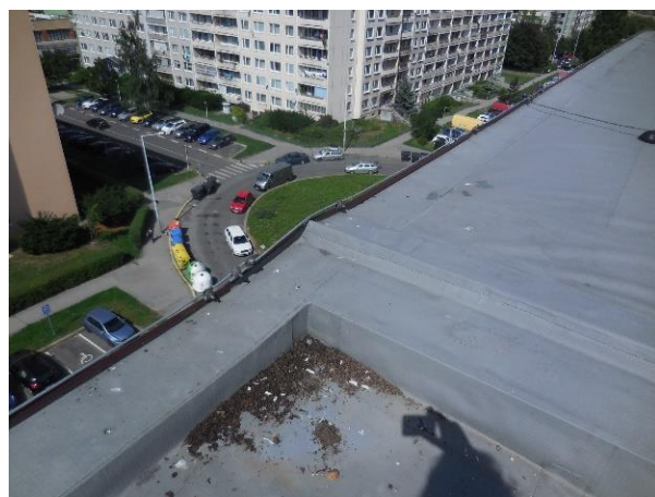
Obr. 7 Realizovaný detail dilatační atiky
