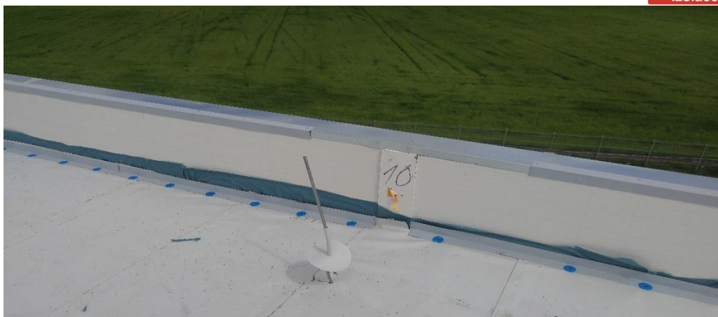
Absence části koutové lišty, kotevní prvky jsou fixovány v okraji koutové lišty
