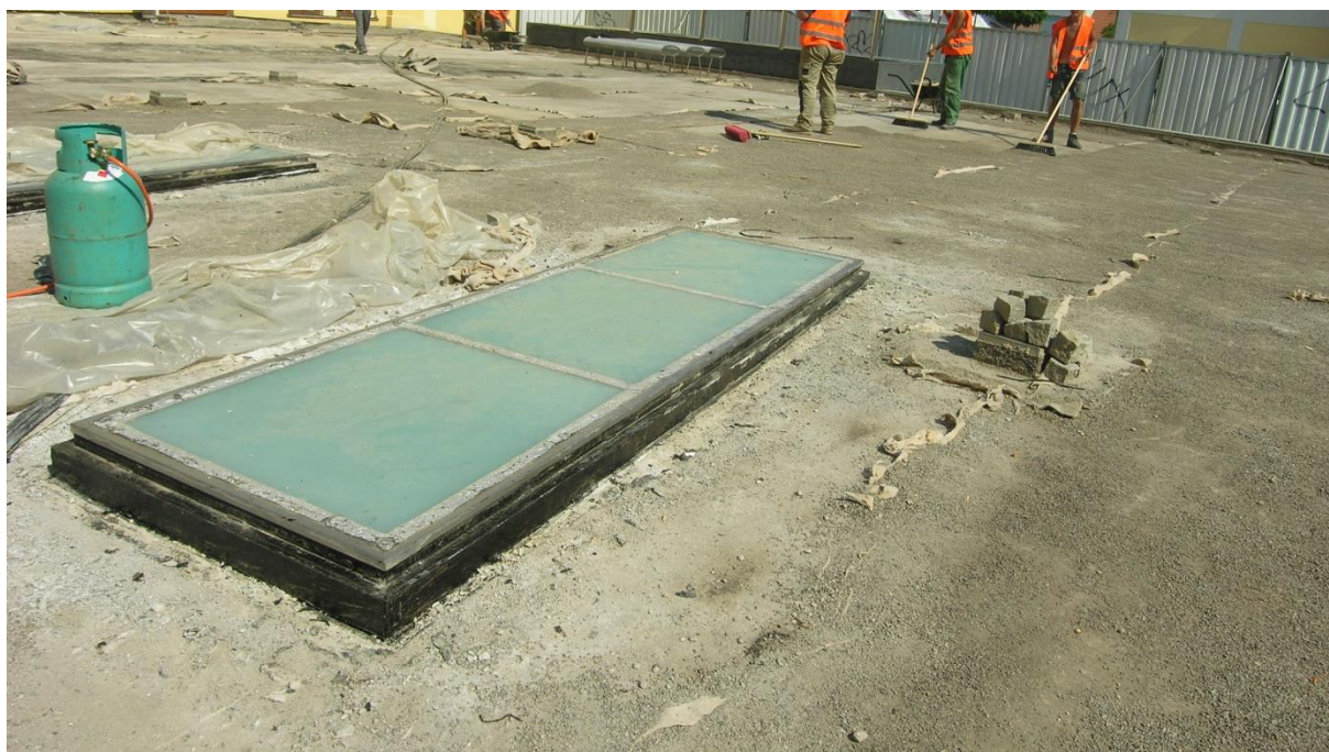
Obr. č. 5 – Odhalené světlíky s pochozím prosklením
