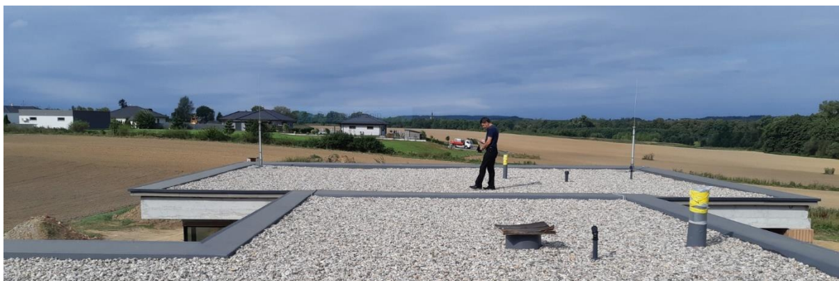
4) Úsekové měření senzorů na střeše bungalovu v Kostelci nad Orlicí
