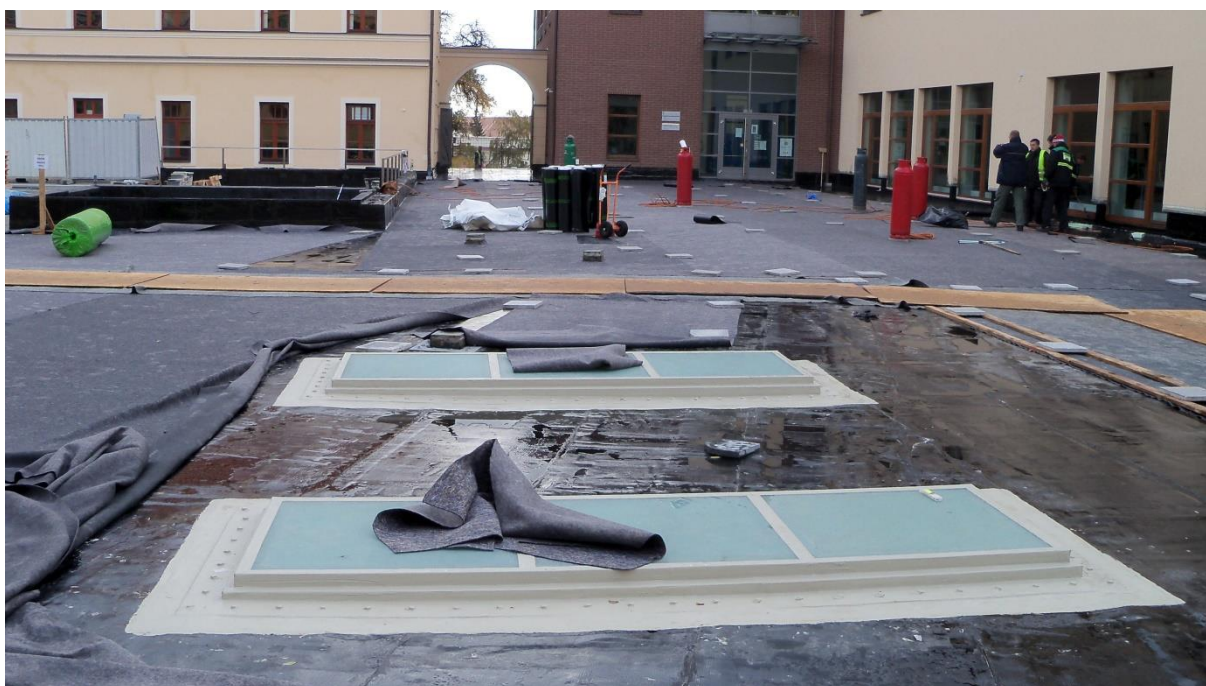
Obr. č. 28 – Provádění primárních ochranných vrstev
