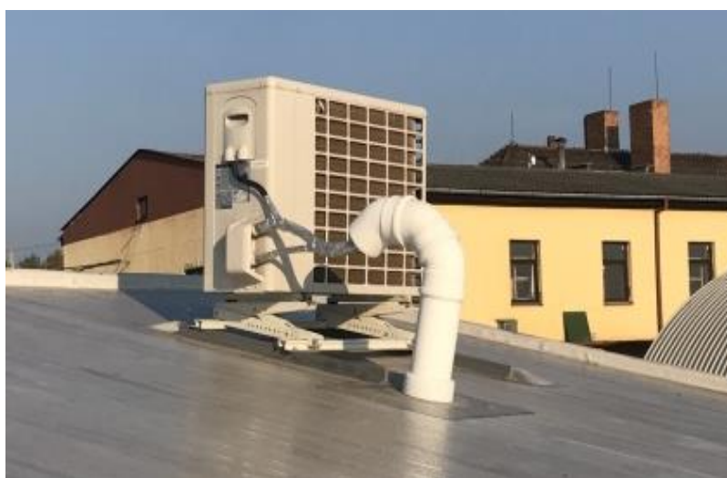
Obr. 6 - Kabelový prostup splňující ČSN (TOPWET - TWP)
