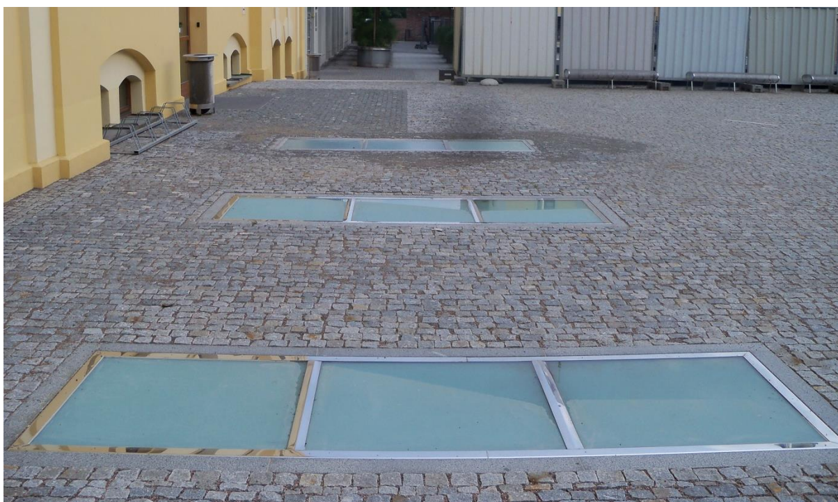
Obr. č. 33 – Definitivní vzhled prosvětlení – světlíků v pochozí vrstvě
