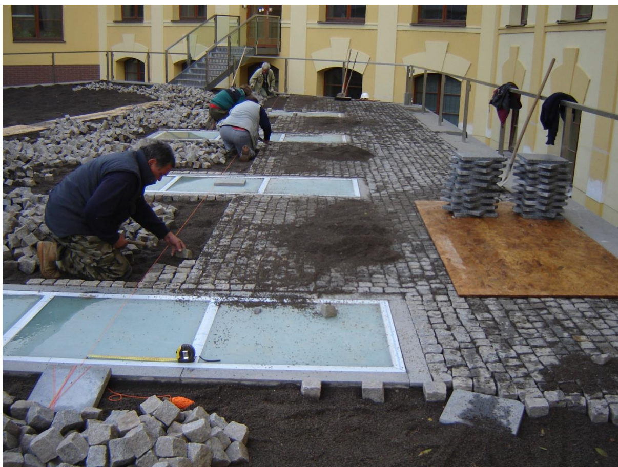
Obr. č. 30 – Provádění pochozí úpravy kolem světlíků
