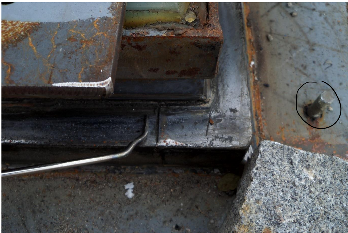
Obr. č. 10 – Detail pevné příruby, připravené pro osazení hydroizolace
