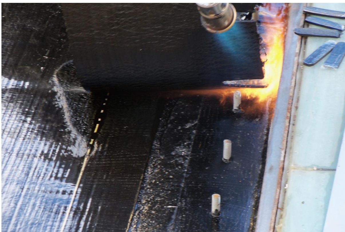
Obr. č. 14 – Navařování zesilujícího pruhu asfaltové hydroizolace pod volnou přírubu
