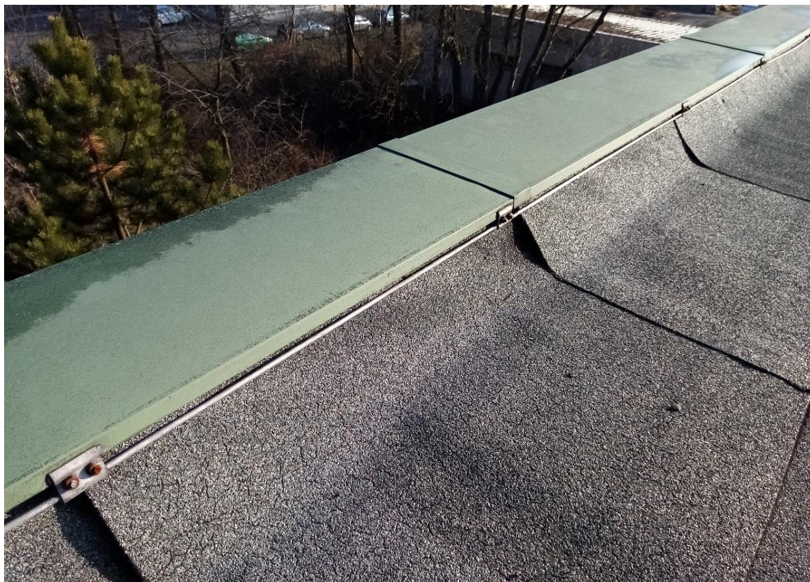
Obr. č. 1 – stávající opracování atiky z doby výstavby objektu.
