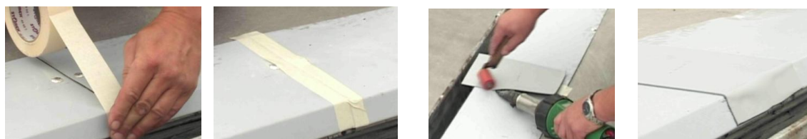
Obr. 5: Napojení profilů z poplastovaného plechu – příklad u okapnice
