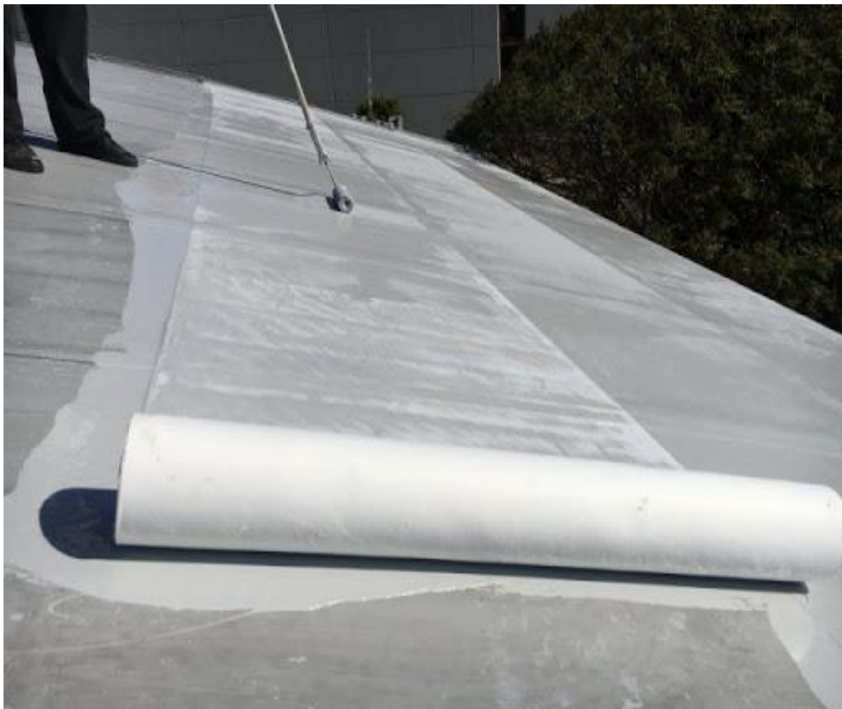
Obr. č. 2 – Provádění 1.vrstvy PUR membrány weberdry pur seal s vkládáním geotextili weberdry fabric
